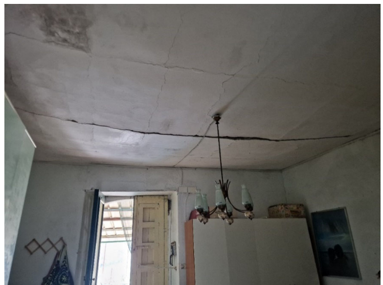
FO_ 20 Controsoffitto vano uno UNITA' TRE
