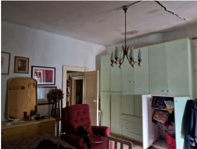
FO_ 19 Vano di ingresso all'UNITA' TRE
