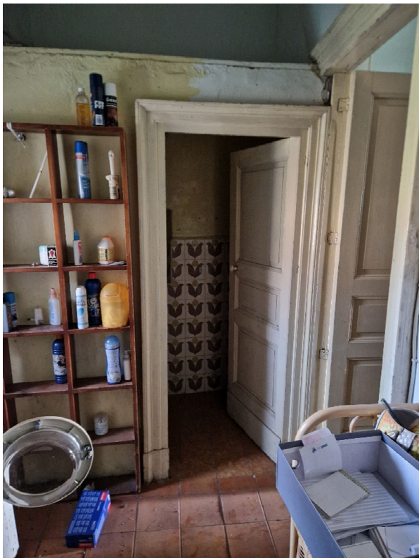
FO_ 22 Porta di accesso al bagno UNITA' TRE
