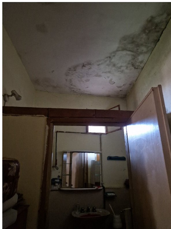
FO_ 14 Particolare controsoffitto disimpegno/bagno UNITA' DUE
