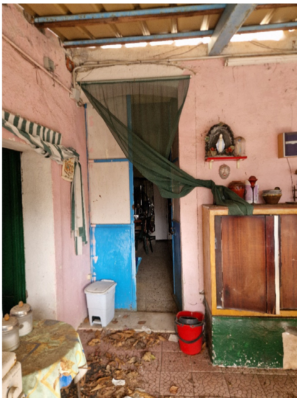
FO_ 9 Ingresso UNITA' DUE
