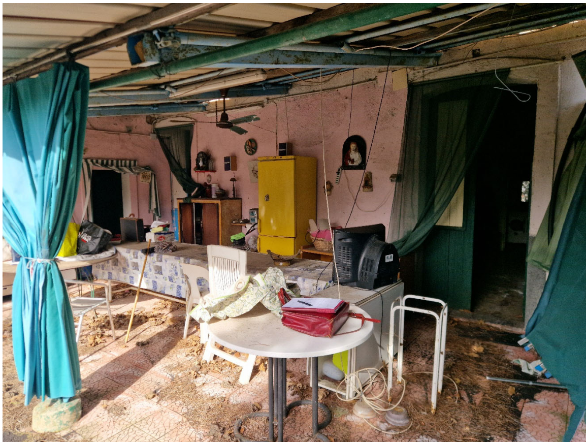
FO_ 3 Prospetto Sud: accessi alle tre unità (tettoia antistante il fabbricato)
