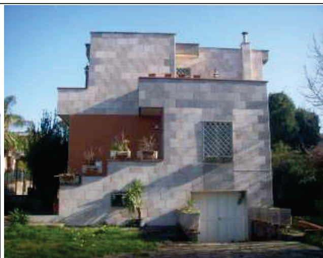
(foto 2: prospetto lato giardino)
