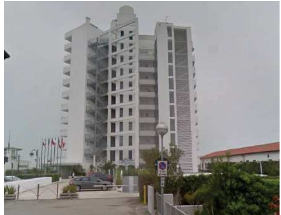
Foto 1 | Vista dell'edificio da via Vittorio Veneto
