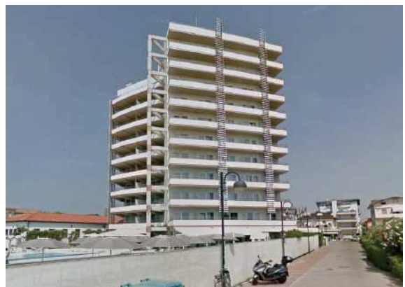
Foto 2 | Vista dall'accesso al mare
