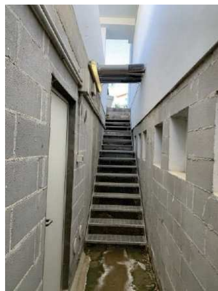
Foto 4 | Scala di accesso
