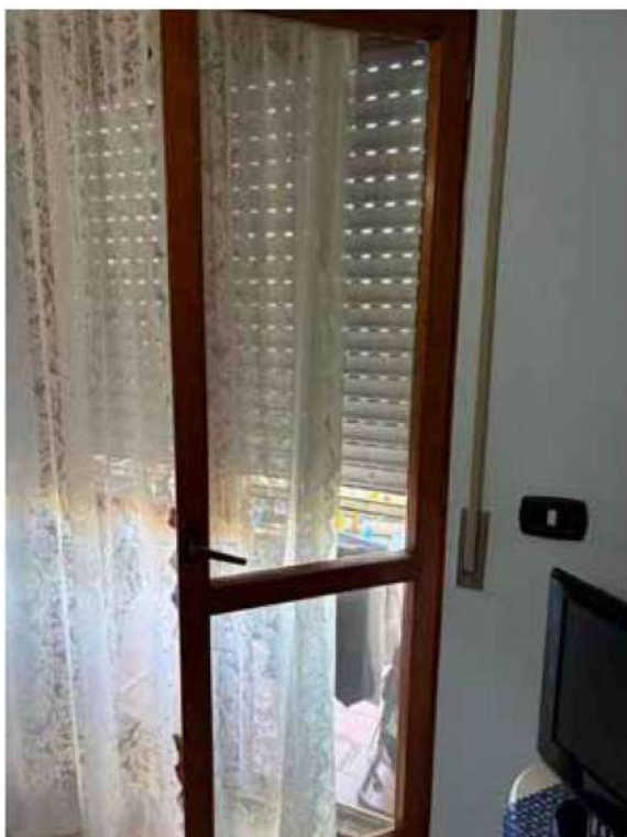
Foto 9: Particolare infisso esterno
