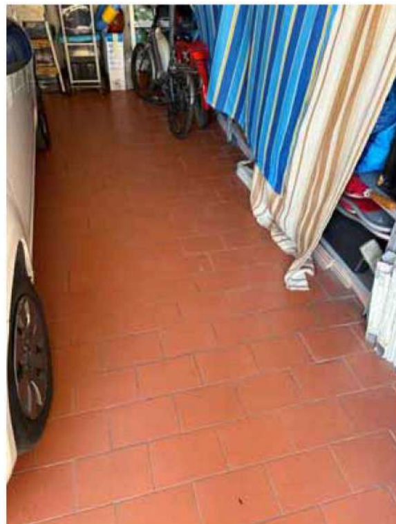
Foto 2: Particolare pavimento interno
