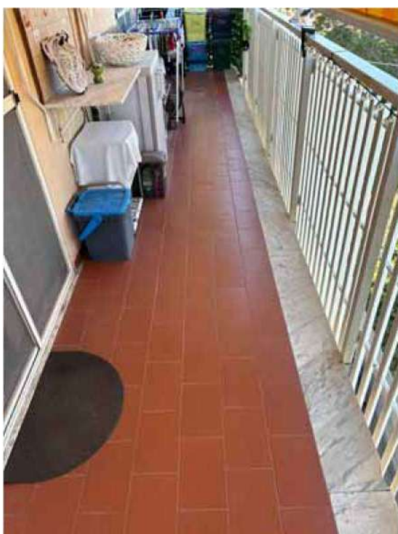
Foto 11: Particolare pavimentazione balcone
