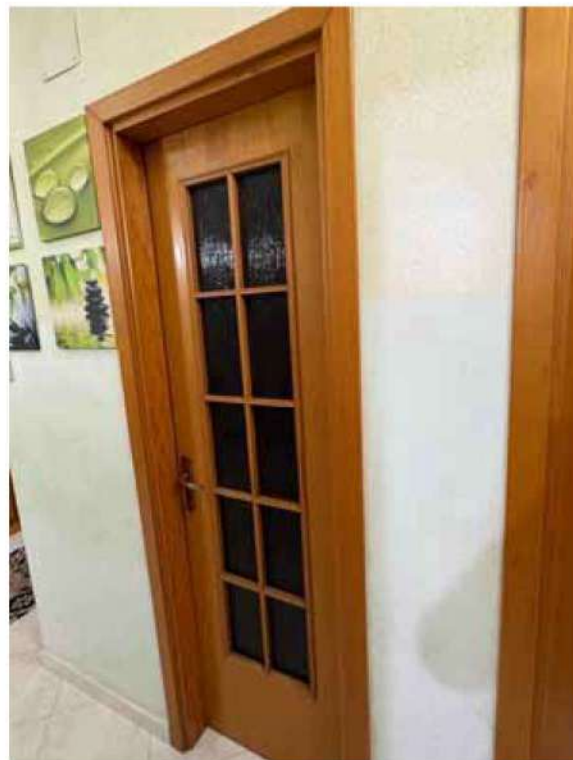
Foto 6: Particolare porta interna
