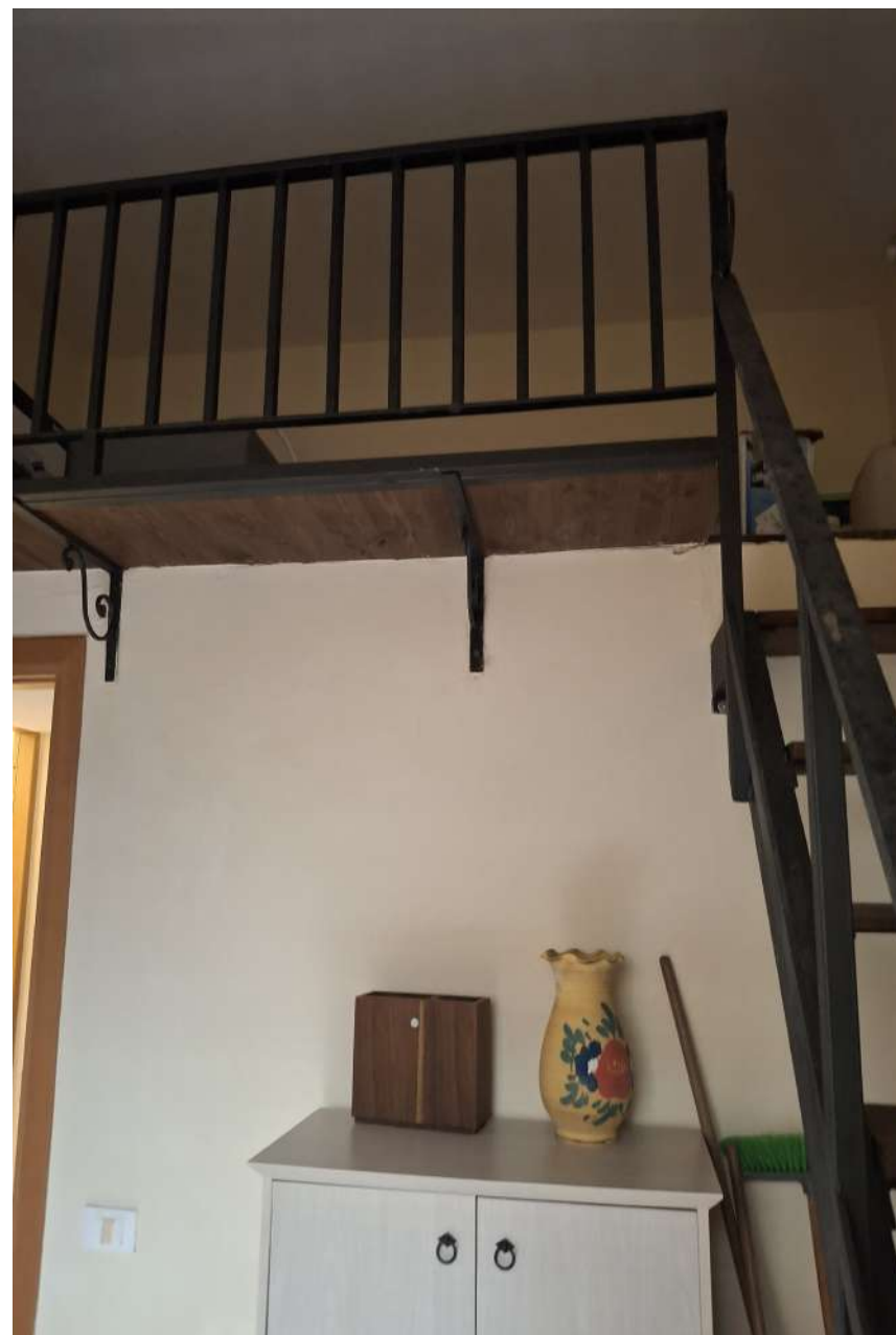
SOPPALCO SOPRA IL BAGNO
