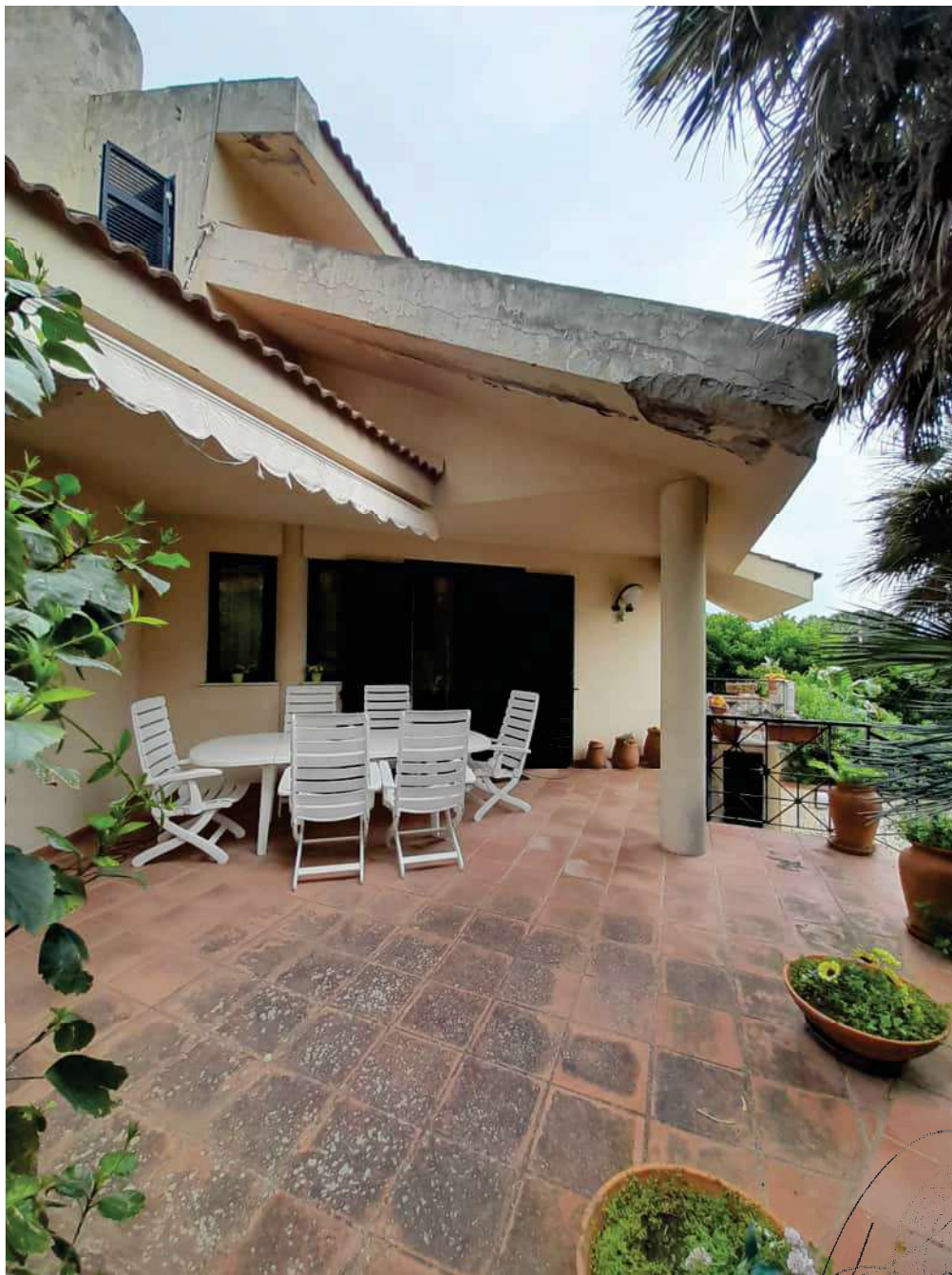
Foto n°7 - Particolare della veranda coperta con accesso dalla cucina- soggiorno
