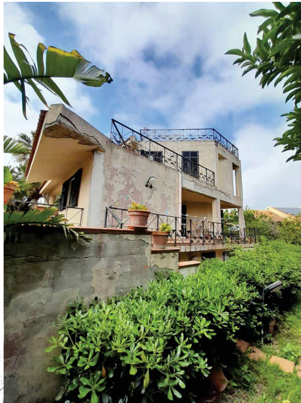
Foto n°4 - Prospetto di Nord-Est
