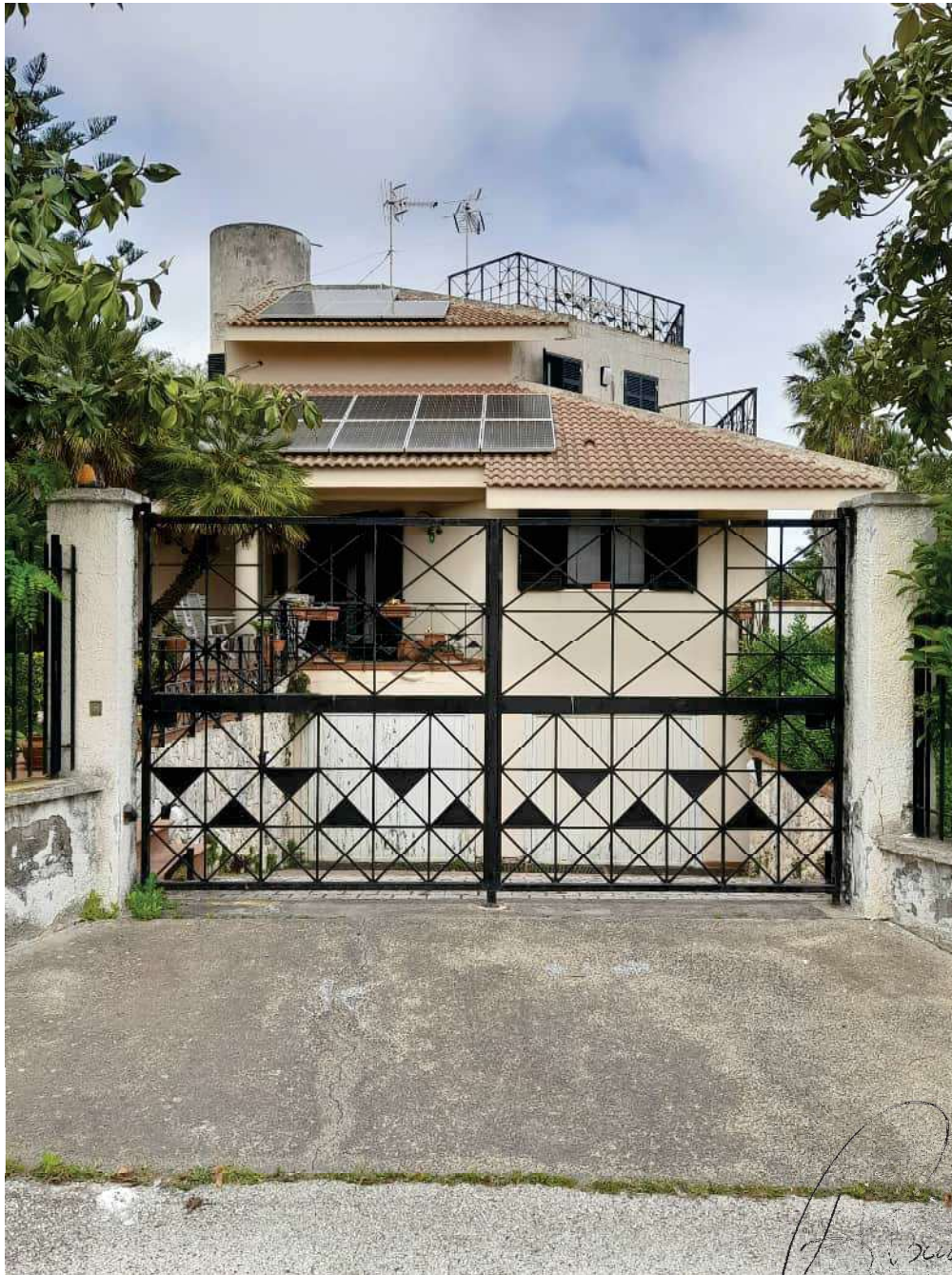
Foto n°5 - Prospetto Sud su via delle Magnolie
