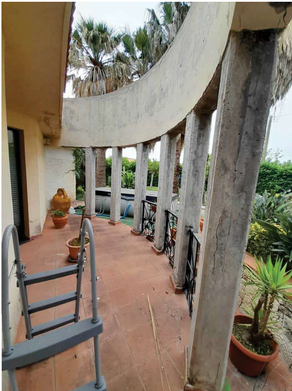
Foto n°9 - Particolare della terrazza con quinta pilastrata con accesso dal salone
