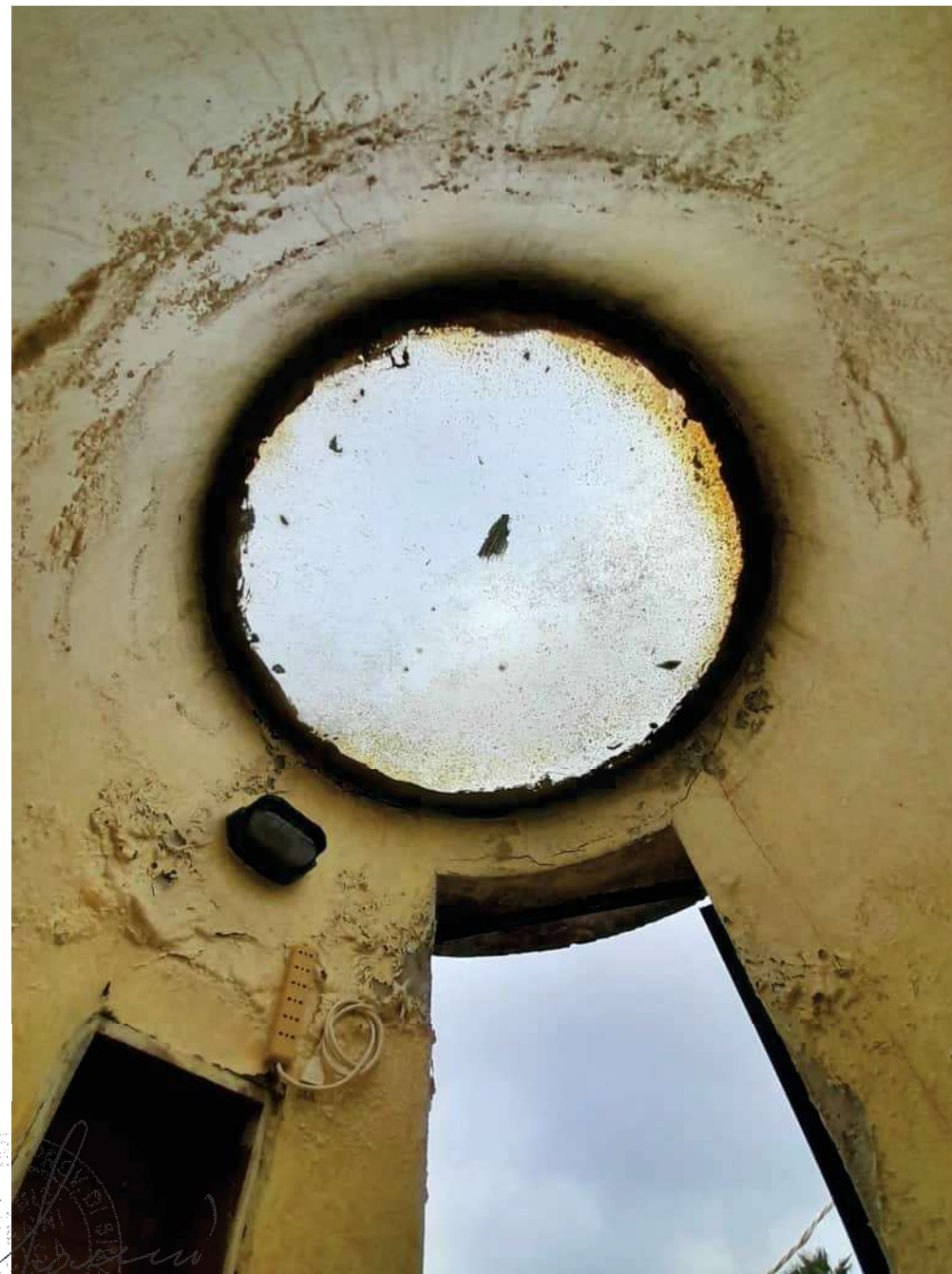
Foto n°28 - Particolare dei danni esistenti nel vano cilindrico che contiene la scala a chiocciola per salire in terrazza
