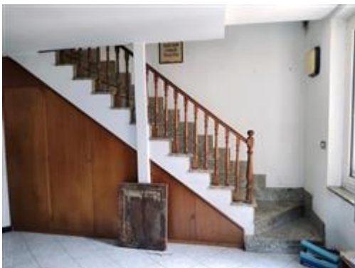
scala d'accesso al piano sottotetto - da rimuovere
