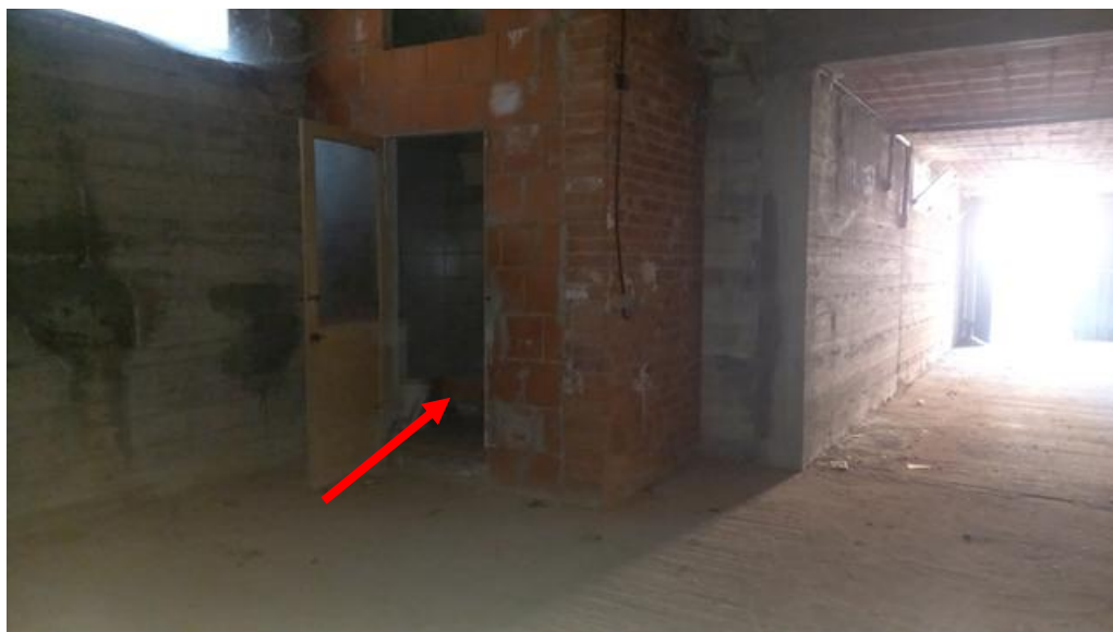
Foto 6: Ingresso Servizio Igienico WC
