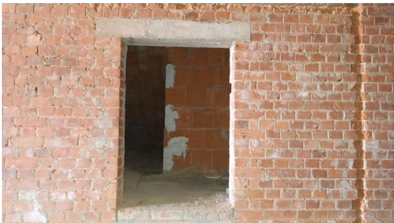
Foto 10: Magazzino – Interno: sottoscala
