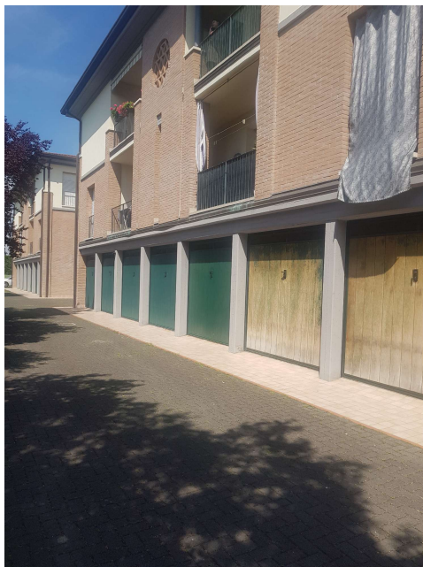
Il retro del fabbricato con le autorimesse
