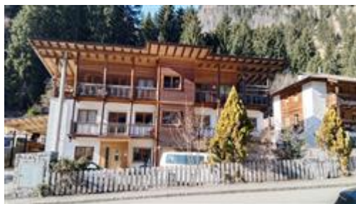
Vista esterna dell'edificio
