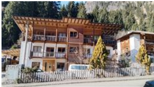
Vista esterna dell'edificio
