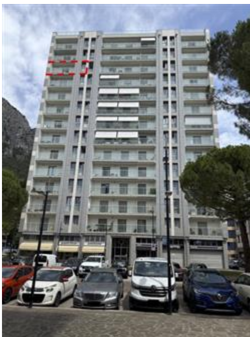
Immobile sito a LECCO in Piazzale dei Cappuccini n. 9 – Prospetto sud-ovest – Appartamento piano undicesimo – Foglio CAS/1, Particella 1402 Sub. 25 (A/2)
