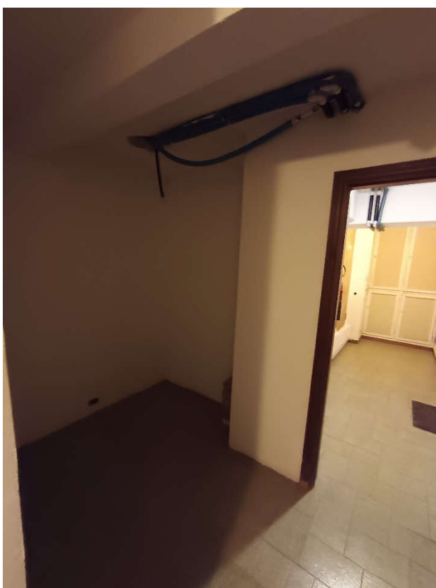
ripostiglio piano seminterrato
