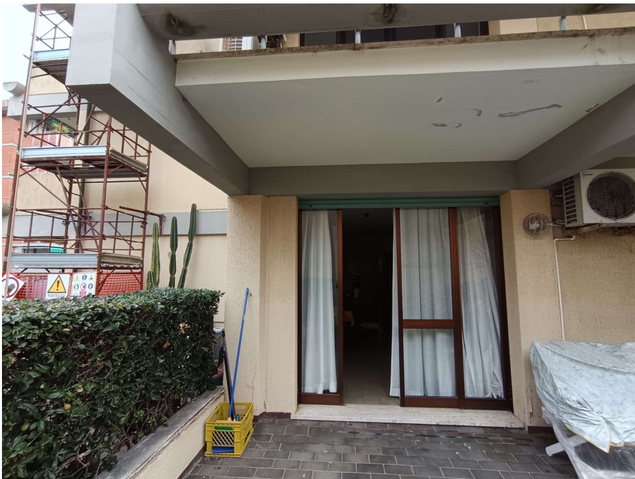
accesso al cortile esterno dal soggiorno
