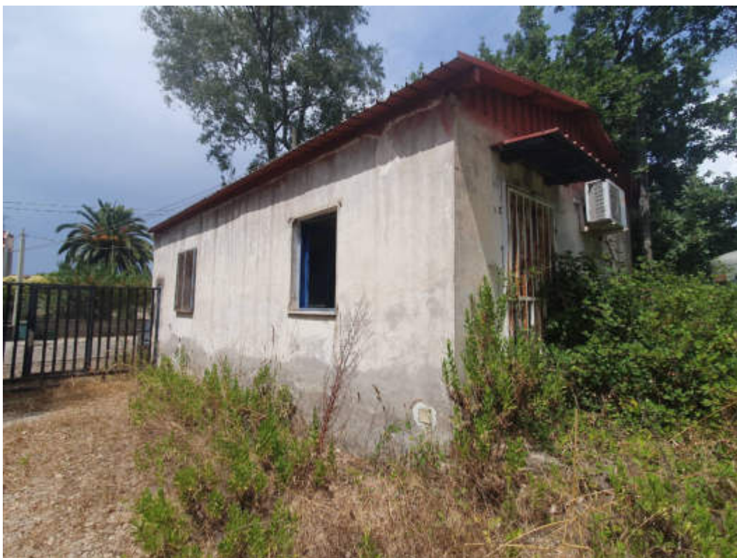
FOTO N. 2: COMPLESSO INDUSTRIALE SITO IN SESSA AURUNCA ALLA STRADA PROVINCIALE N.132 CENSITO IN N.C.F. AL FOGLIO 189 P.LLA 92 SUB 1 FABBRICATO UFFICI - VISUALE SUD-OVEST
