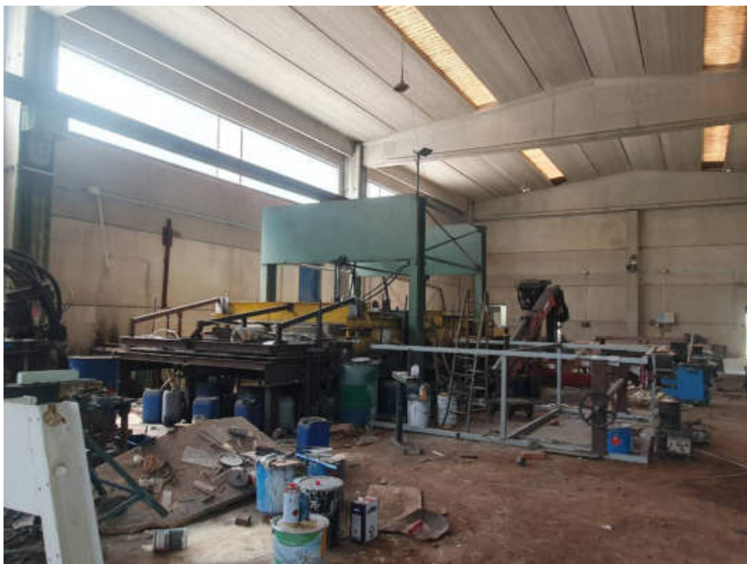
FOTO N. 12: COMPLESSO INDUSTRIALE SITO IN SESSA AURUNCA ALLA STRADA PROVINCIALE N.132 CENSITO IN N.C.F. AL FOGLIO 189 P.LLA 92 SUB 1 CAPANNONE 1 – INTERNI IN TOTALE STATO DI ABBANDONO E DI DEGRADO
