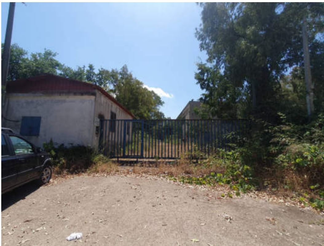
FOTO N. 1: COMPLESSO INDUSTRIALE SITO IN SESSA AURUNCA ALLA STRADA PROVINCIALE N.132 CENSITO IN N.C.F. AL FOGLIO 189 P.LLA 92 SUB 1 INGRESSO ALL'AREA - VISUALE NORD
