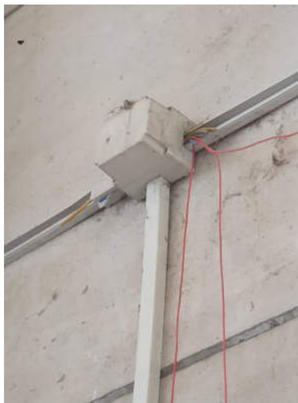
FOTO NN. 14-15: COMPLESSO INDUSTRIALE SITO IN SESSA AURUNCA ALLA STRADA PROVINCIALE N.132 CENSITO IN N.C.F. AL FOGLIO 189 P.LLA 92 SUB 1 CAPANNONE 1 – PARTICOLARE DELL'IMPIANTO ELETTRICO DEPREDATO
