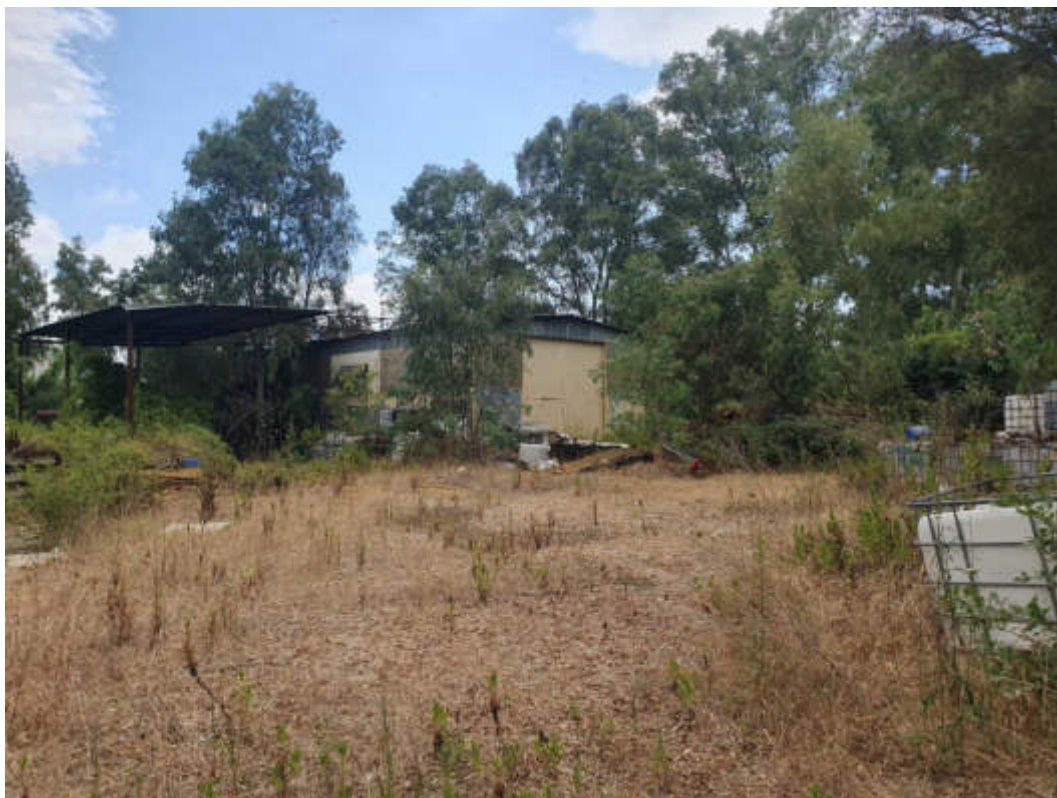
FOTO N. 24: COMPLESSO INDUSTRIALE SITO IN SESSA AURUNCA ALLA STRADA PROVINCIALE N.132 CENSITO IN N.C.F. AL FOGLIO 189 P.LLA 92 SUB 1 AREA ESTERNA AL CAPANNONE 2 INFESTATA DA CESPUGLI DI ROVI E STERPAGLIE
