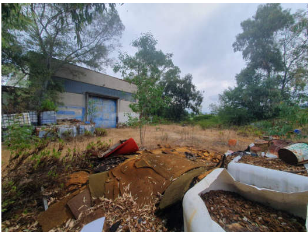
FOTO N. 23: COMPLESSO INDUSTRIALE SITO IN SESSA AURUNCA ALLA STRADA PROVINCIALE N.132 CENSITO IN N.C.F. AL FOGLIO 189 P.LLA 92 SUB 1 AREA ESTERNA AL CAPANNONE 1 INFESTATA DA CESPUGLI DI ROVI E STERPAGLIE VISUALE SUD-OVEST
