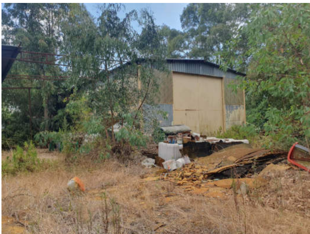
FOTO N. 25: COMPLESSO INDUSTRIALE SITO IN SESSA AURUNCA ALLA STRADA PROVINCIALE N.132 CENSITO IN N.C.F. AL FOGLIO 189 P.LLA 92 SUB 1 AREA ESTERNA AL CAPANNONE 2 INFESTATA DA CESPUGLI DI ROVI E STERPAGLIE
