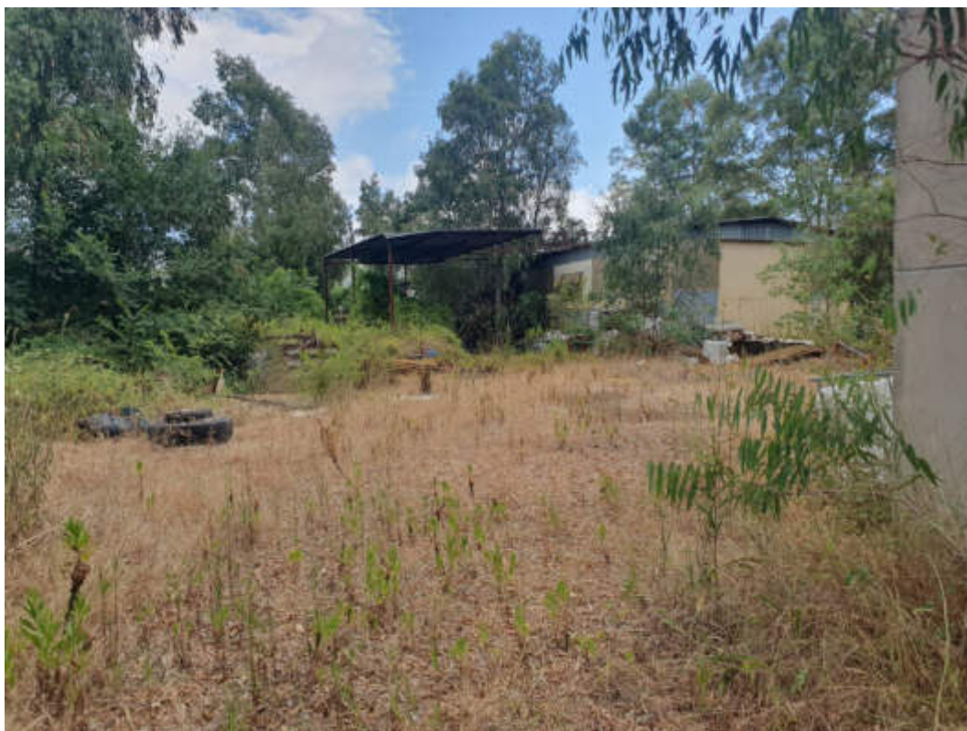
FOTO N. 21: COMPLESSO INDUSTRIALE SITO IN SESSA AURUNCA ALLA STRADA PROVINCIALE N.132 CENSITO IN N.C.F. AL FOGLIO 189 P.LLA 92 SUB 1 AREA ESTERNA TRA CAPANNONE 1 E CAPANNONE 2 INFESTATA DA CESPUGLI DI ROVI E STERPAGLIE
