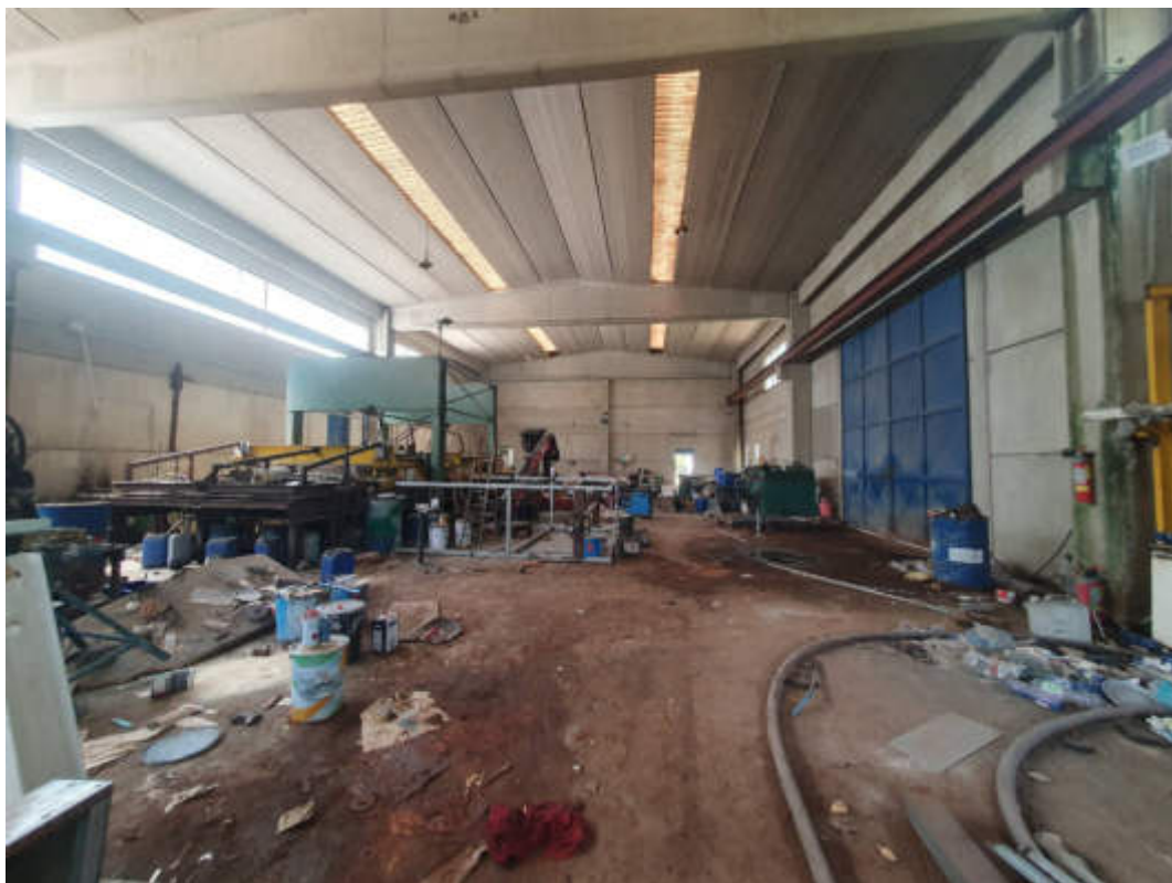
FOTO N. 11: COMPLESSO INDUSTRIALE SITO IN SESSA AURUNCA ALLA STRADA PROVINCIALE N.132 CENSITO IN N.C.F. AL FOGLIO 189 P.LLA 92 SUB 1 CAPANNONE 1 – INTERNI IN TOTALE STATO DI ABBANDONO E DI DEGRADO
