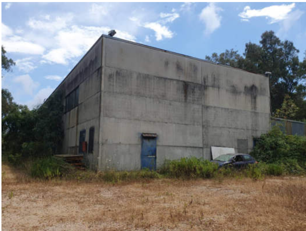
FOTO N. 7: COMPLESSO INDUSTRIALE SITO IN SESSA AURUNCA ALLA STRADA PROVINCIALE N.132 CENSITO IN N.C.F. AL FOGLIO 189 P.LLA 92 SUB 1 CAPANNONE 1 - VISUALE NORD-EST
