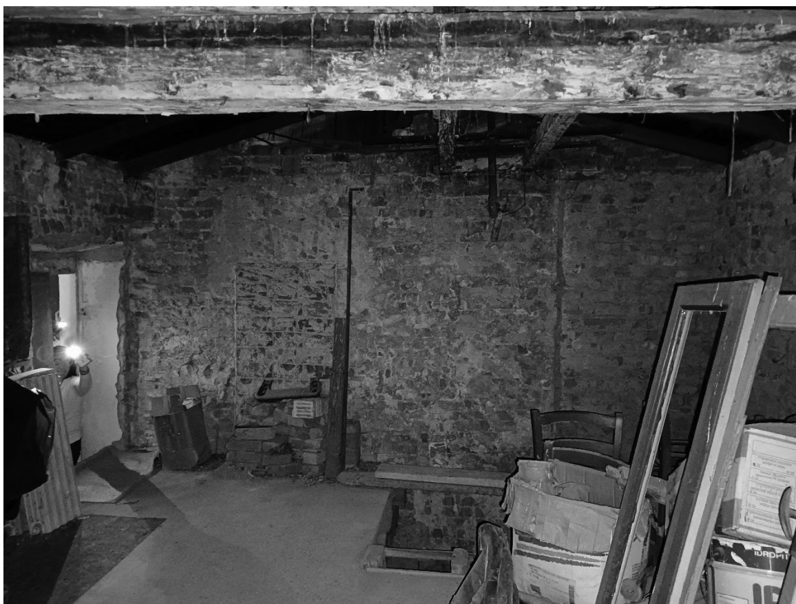
Fg.12 Mapp.226 Sub.701 – Sottotetto
