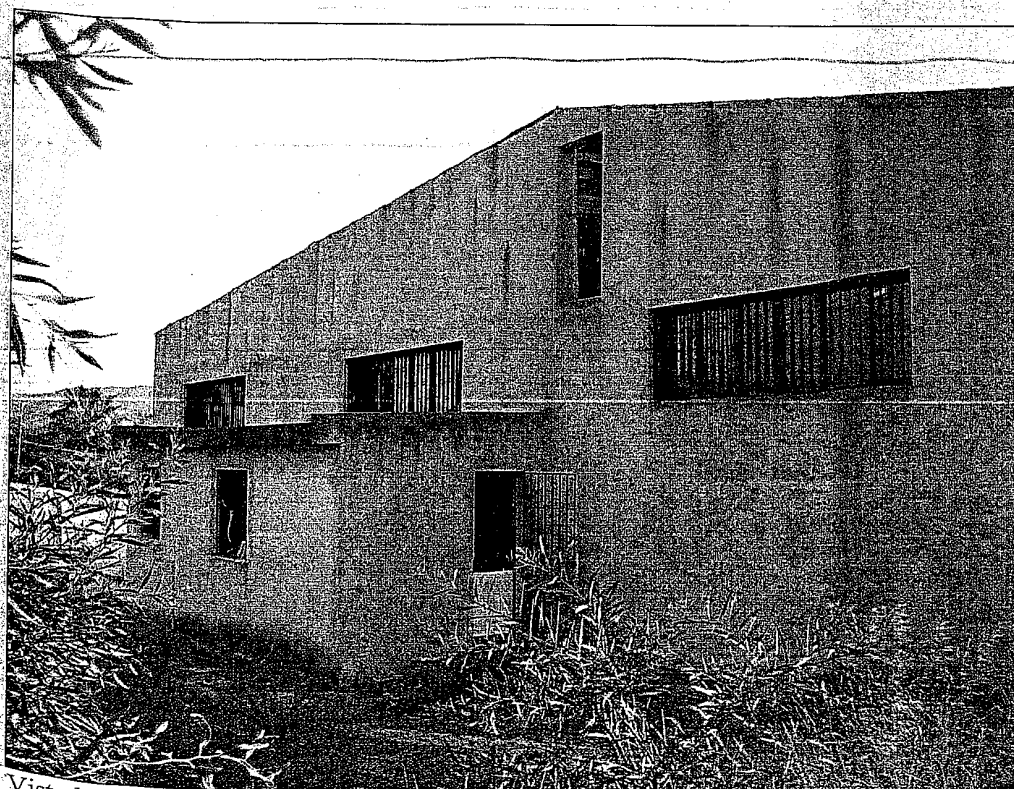
Vista laterale (immobile n.9)
