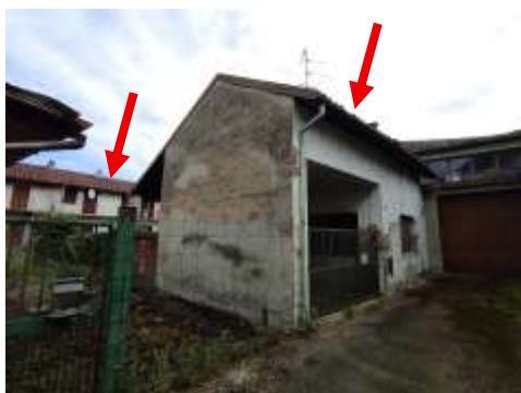
FABBRICATO OVE E' PRESENTE L'ANDRONE PEDONALE E CARRAIO
