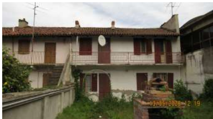
Abitazione u.i. 2430 sub.3
