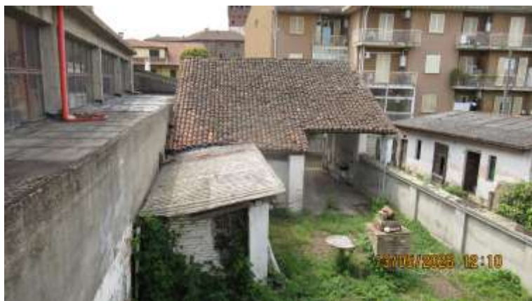
Fabbricati composti sia dalle pertinenze u.i.2430 sub.3 che l'autorimessa u.i. 2430 sub.2
