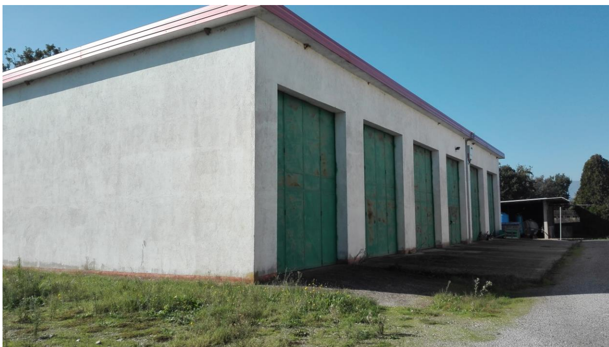
Foto 94. Il fabbricato lato nord est.
