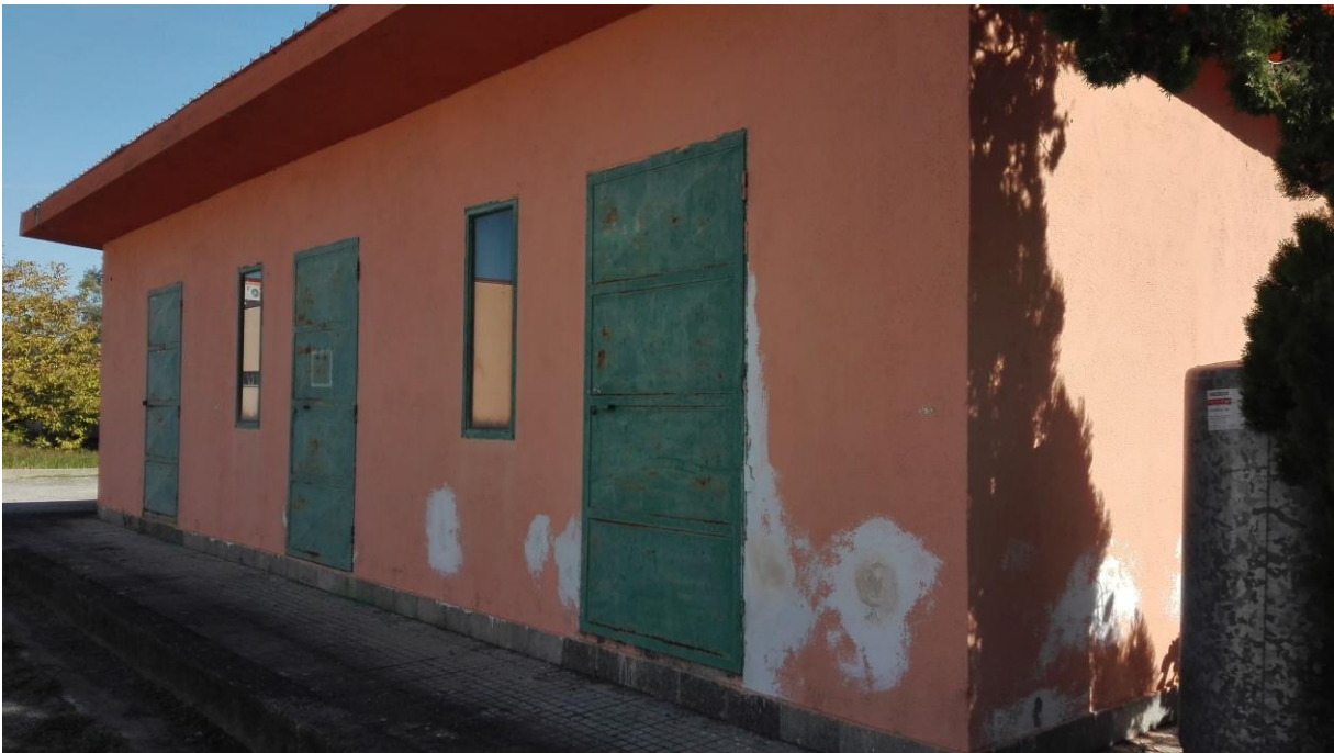
Foto 90. Facciata Corpo C.
