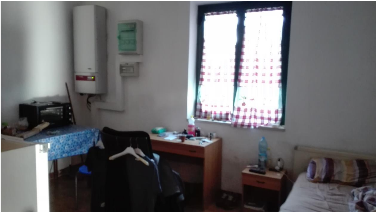
Foto 7-8-9. Particolari dell'interno del fabbricato
