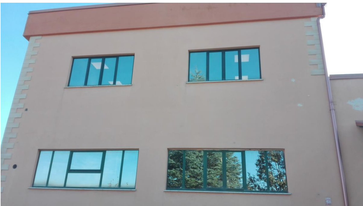
Foto 24. Particolare Lato ovest.
