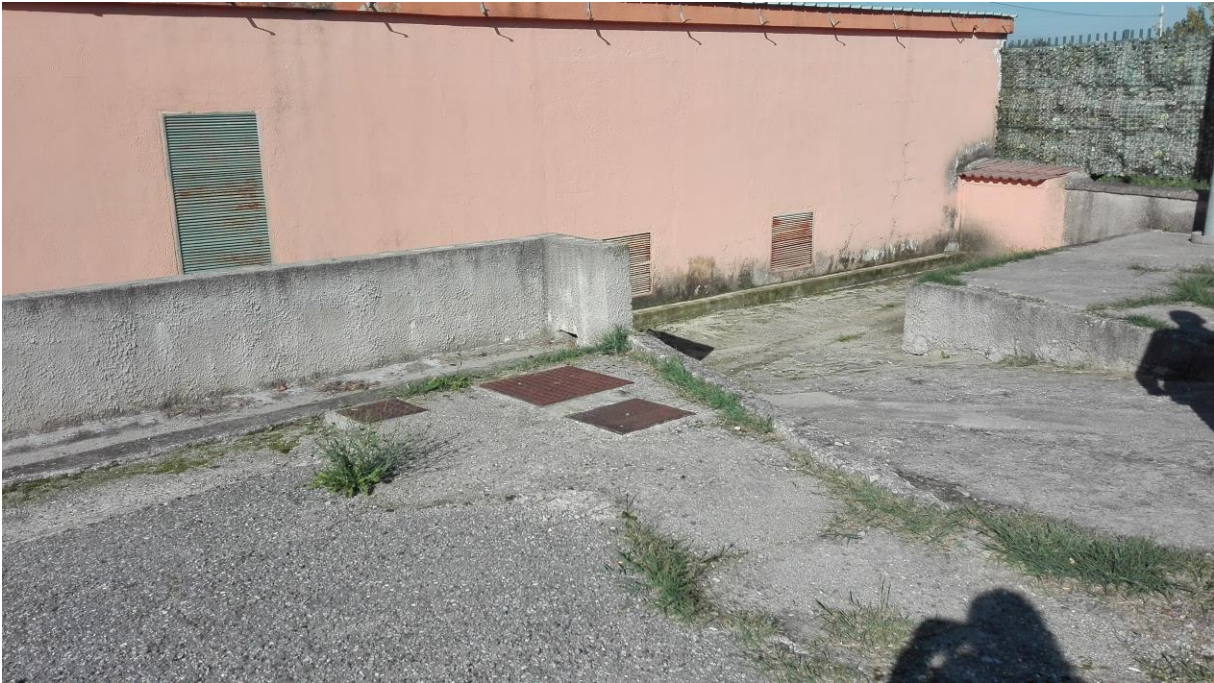
Foto 12-13. Facciata lato est immobile Corpo B
