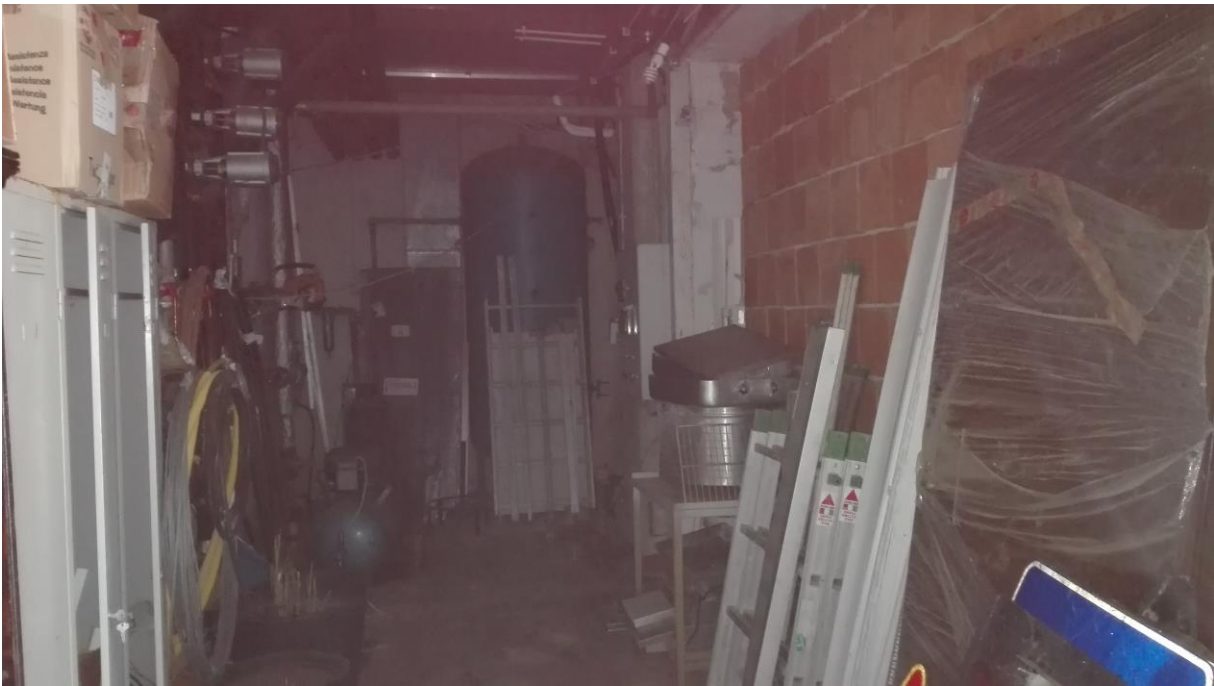
Foto 69-70. Locale deposito magazzino.
