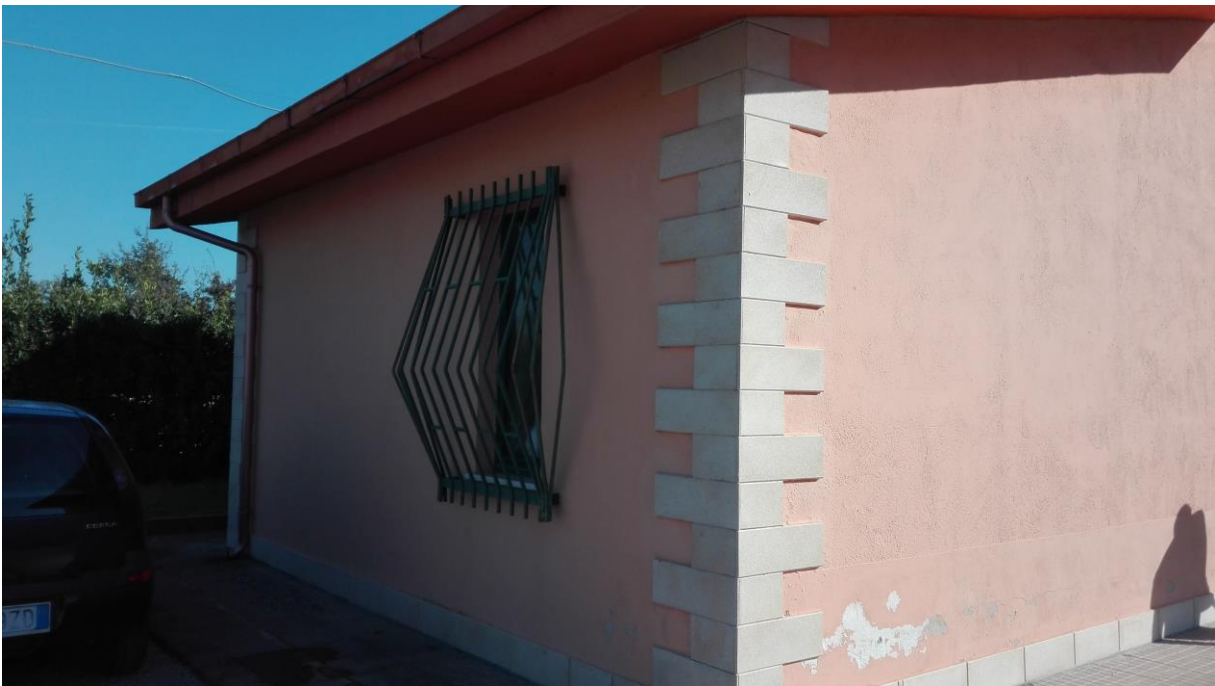
Foto 5-6. Particolari immobile lato nord e lato ovest
