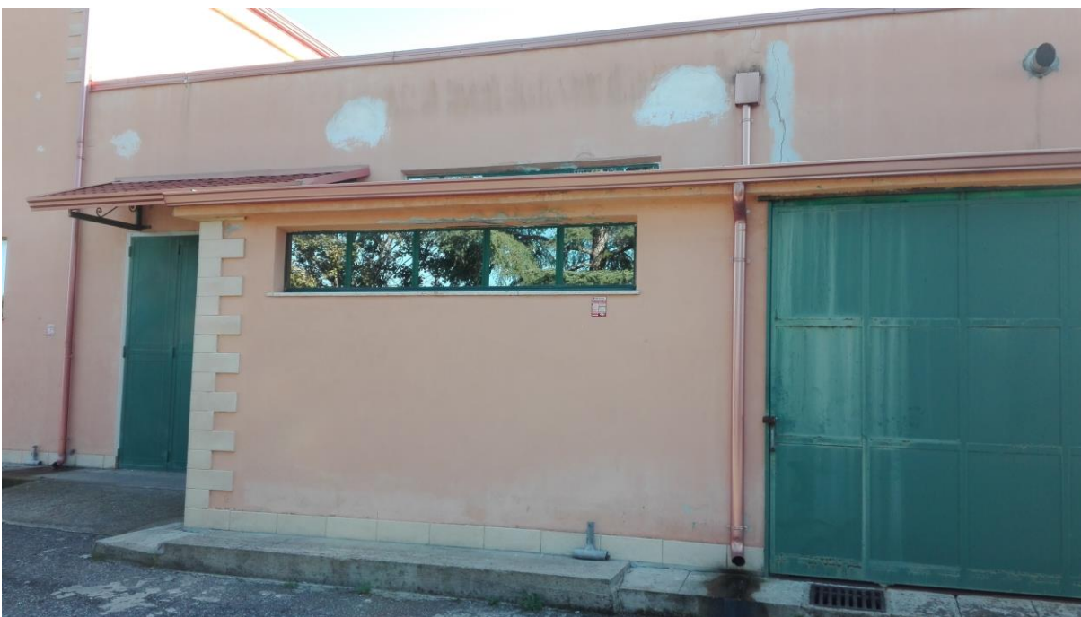
Foto 64. Corpo B lato ovest.
