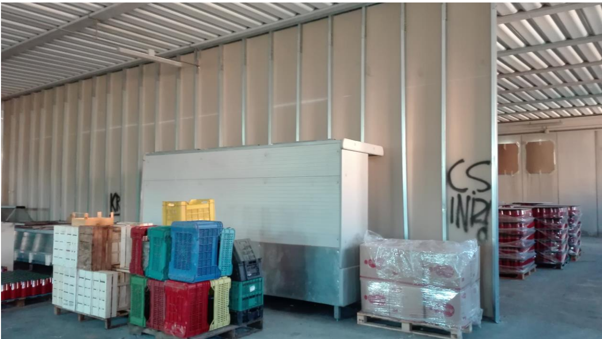
Foto 80-81. Particolari dell'interno del capannone corpo A.
