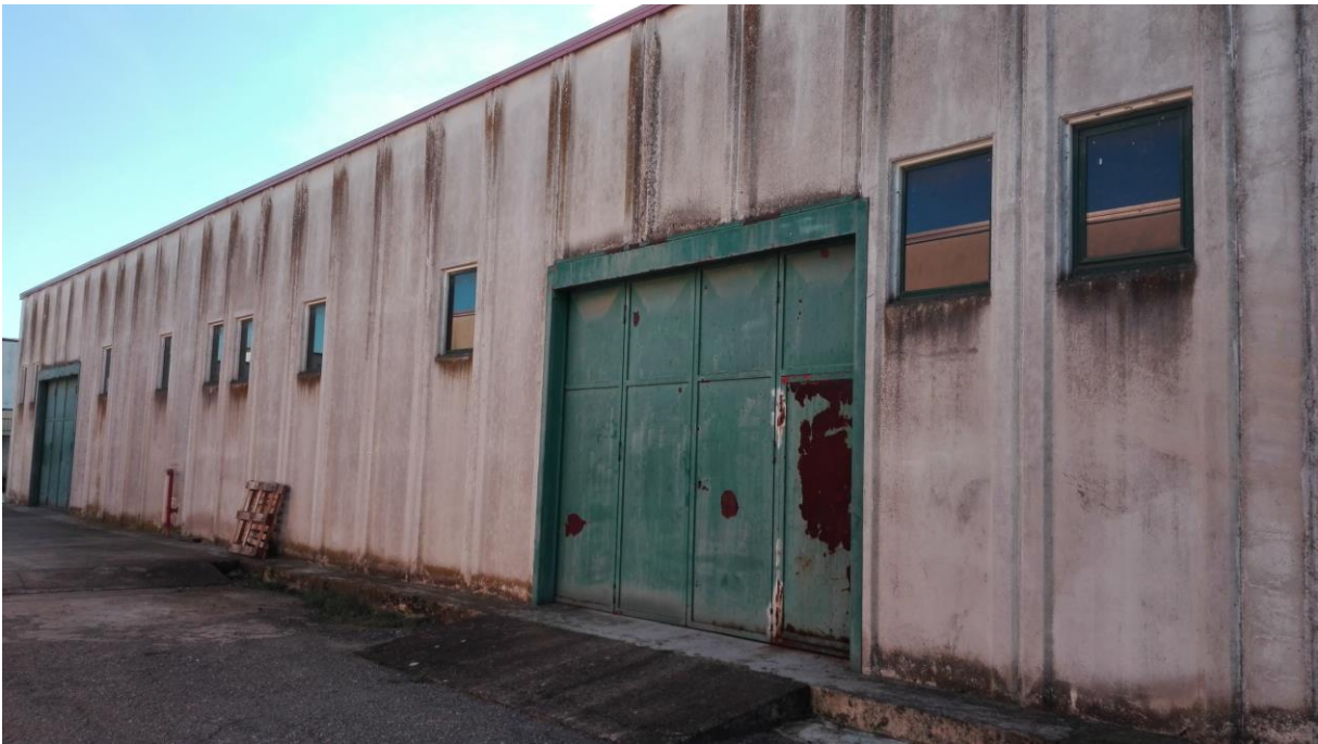
Foto 74. Porta d'ingresso scorrevole al capannone corpo A.
