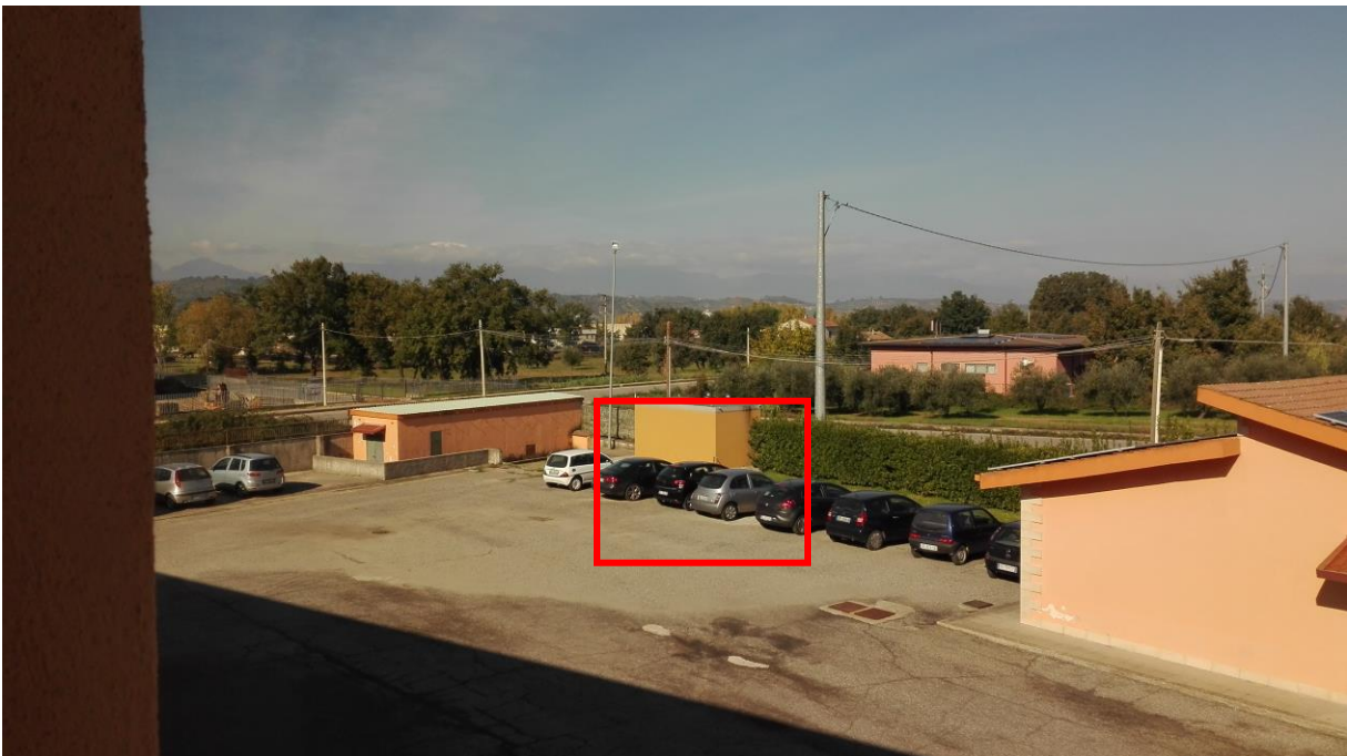
Foto 19-20. Cabina in uso all'Enel.
