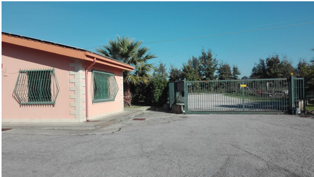
Foto 3-4. Particolari Unità immobiliare part. 62 sub 3 Corpo A
