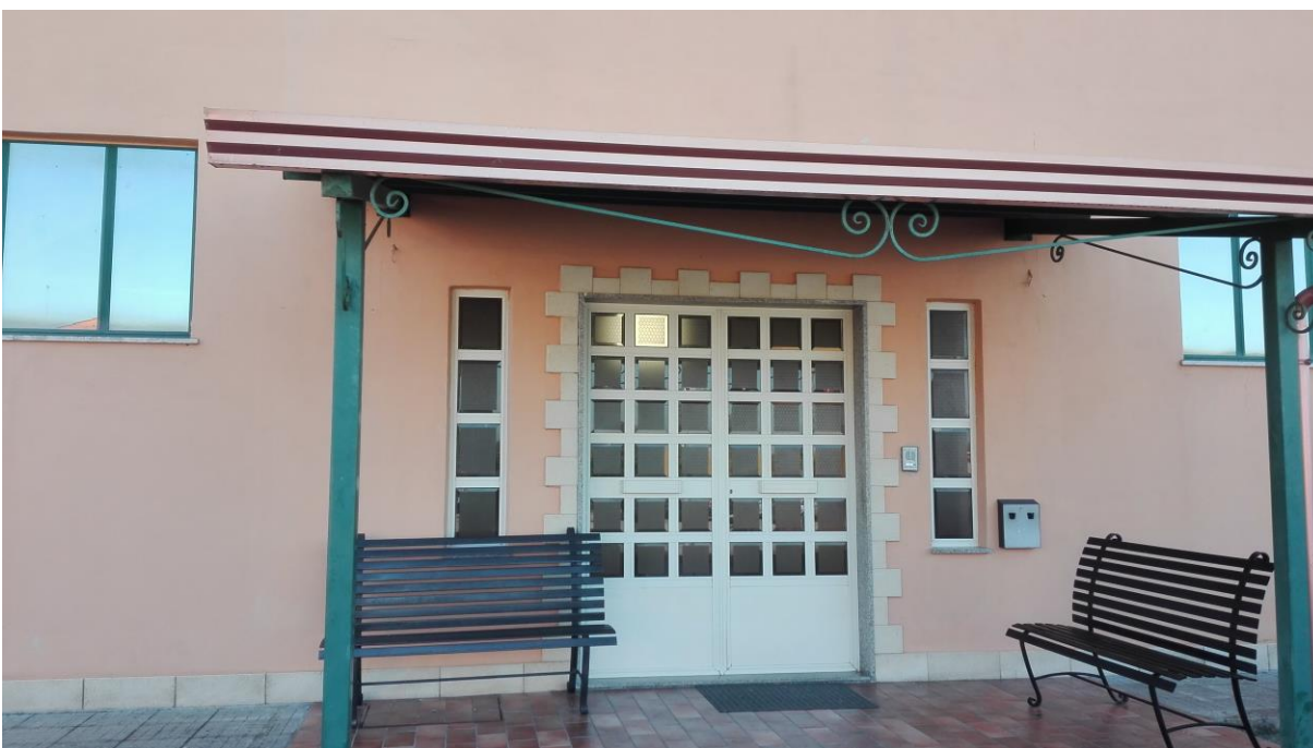
Foto 28. Porta d'ingresso principale corpo A.
