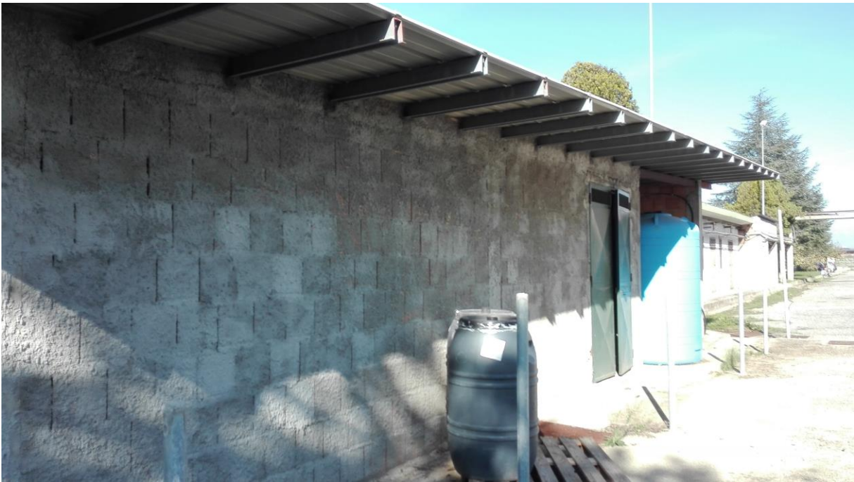
Foto 98. Facciata corpo B.
