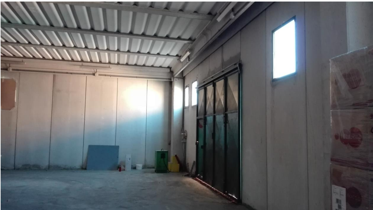
Foto 82-83. Interno del capannone.
