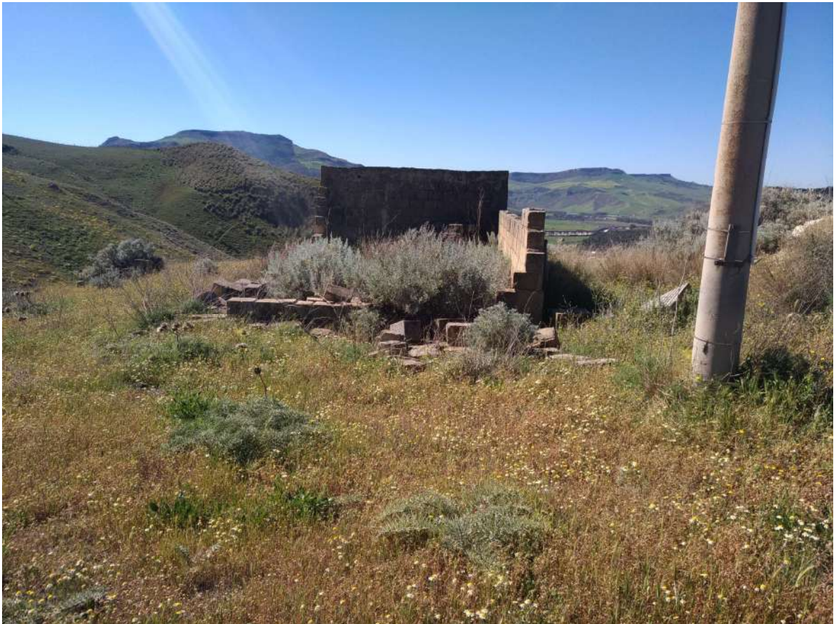
PART. 187 --- FABBRICATO RURALE
