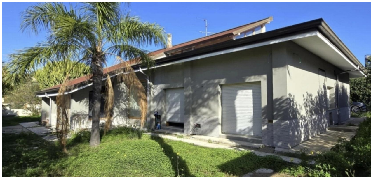
Vista esterna dell'immobile fornita dal committente - immagine non sostitutiva del sopralluogo tecnico.
