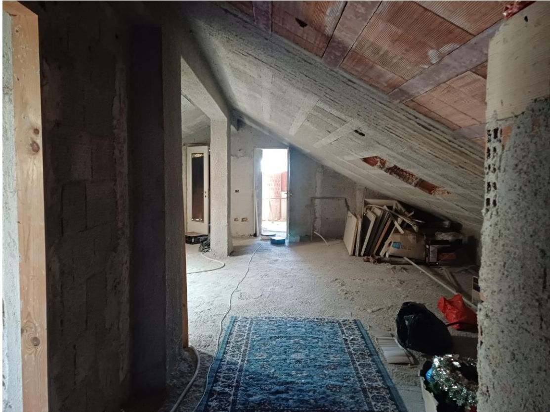
Foto N.32: Sottotetto al piano secondo al rustico
