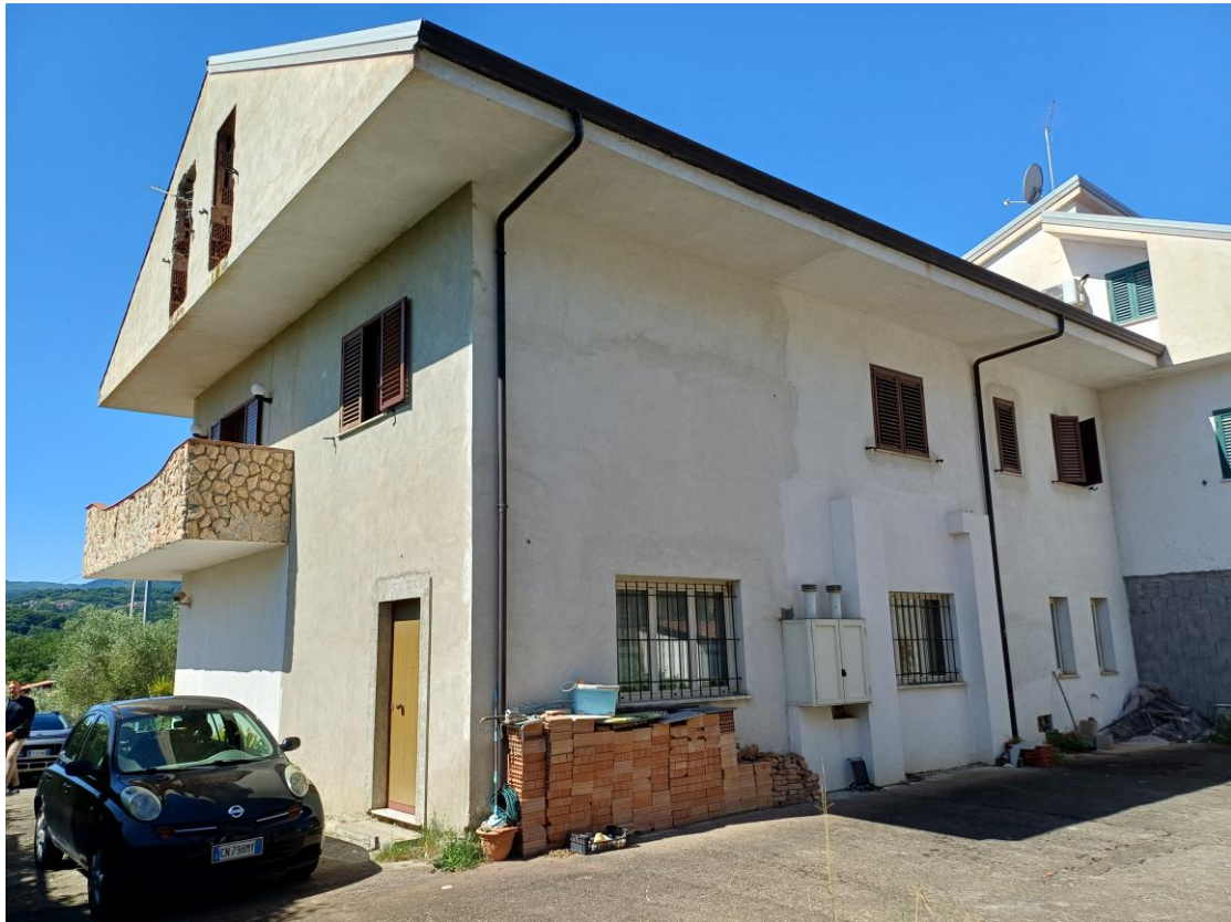
Foto N.1: Prospetto fabbricato Nord-Est
