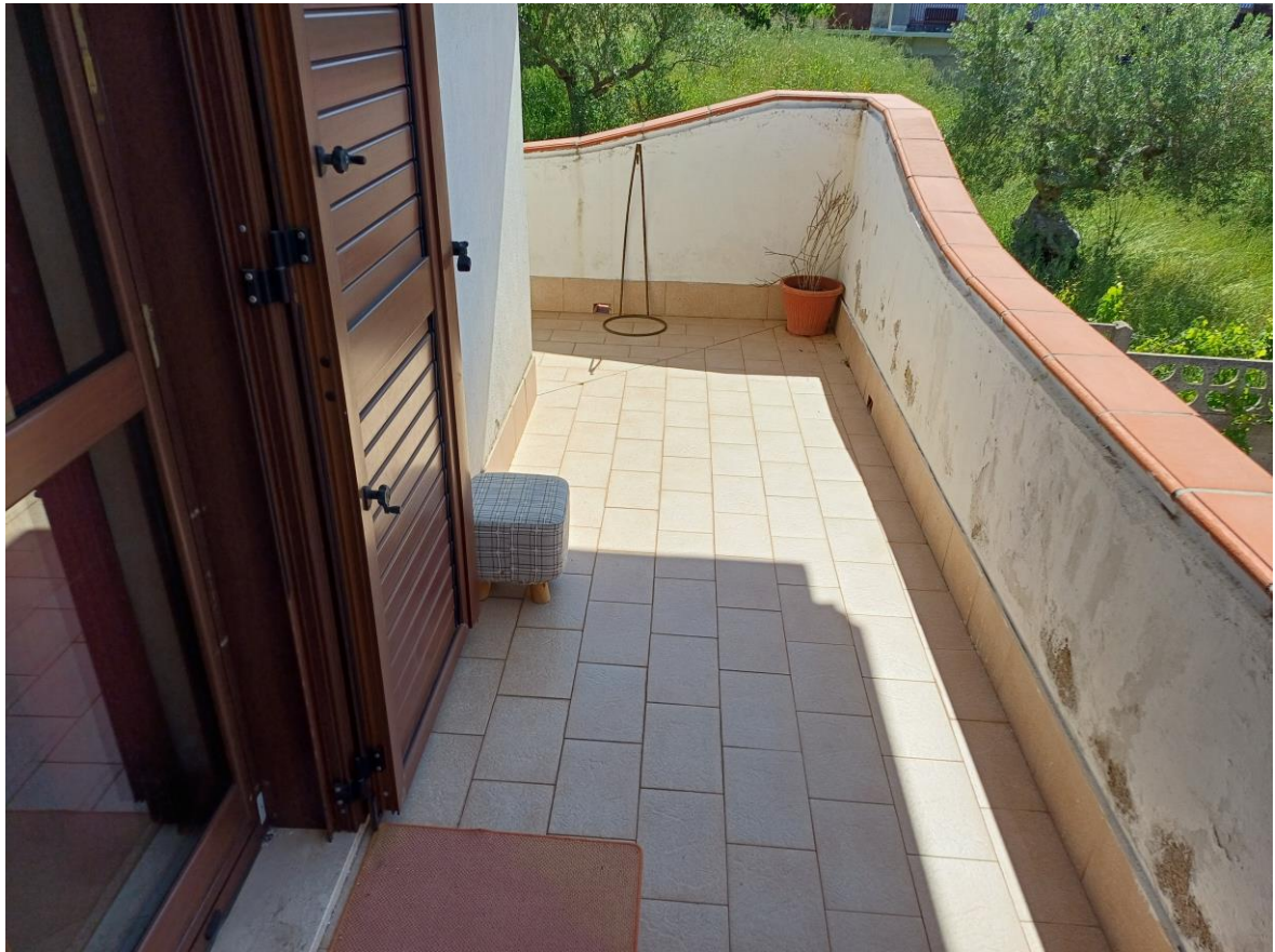
Foto N.11: Balcone lato Sud
