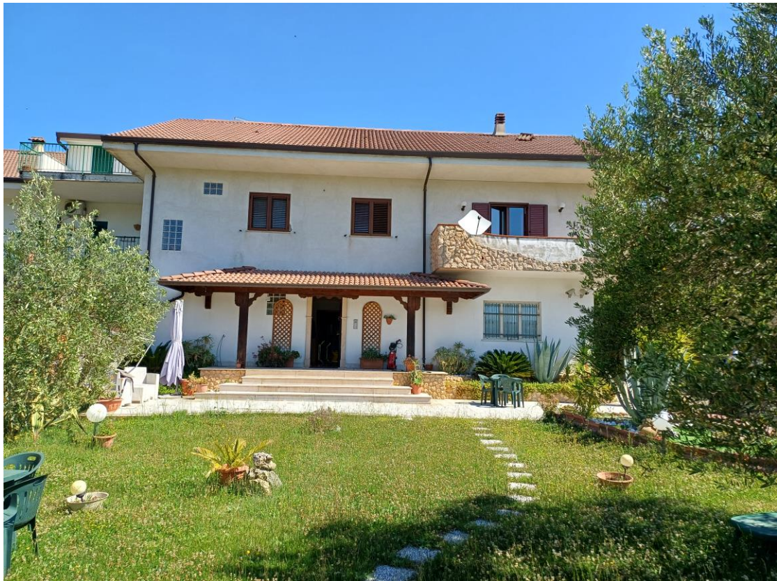
Foto N.3: Prospetto fabbricato Sud
