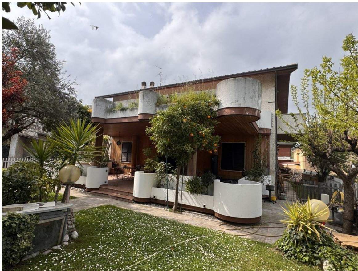
2. Vista lato sud del fabbricato
