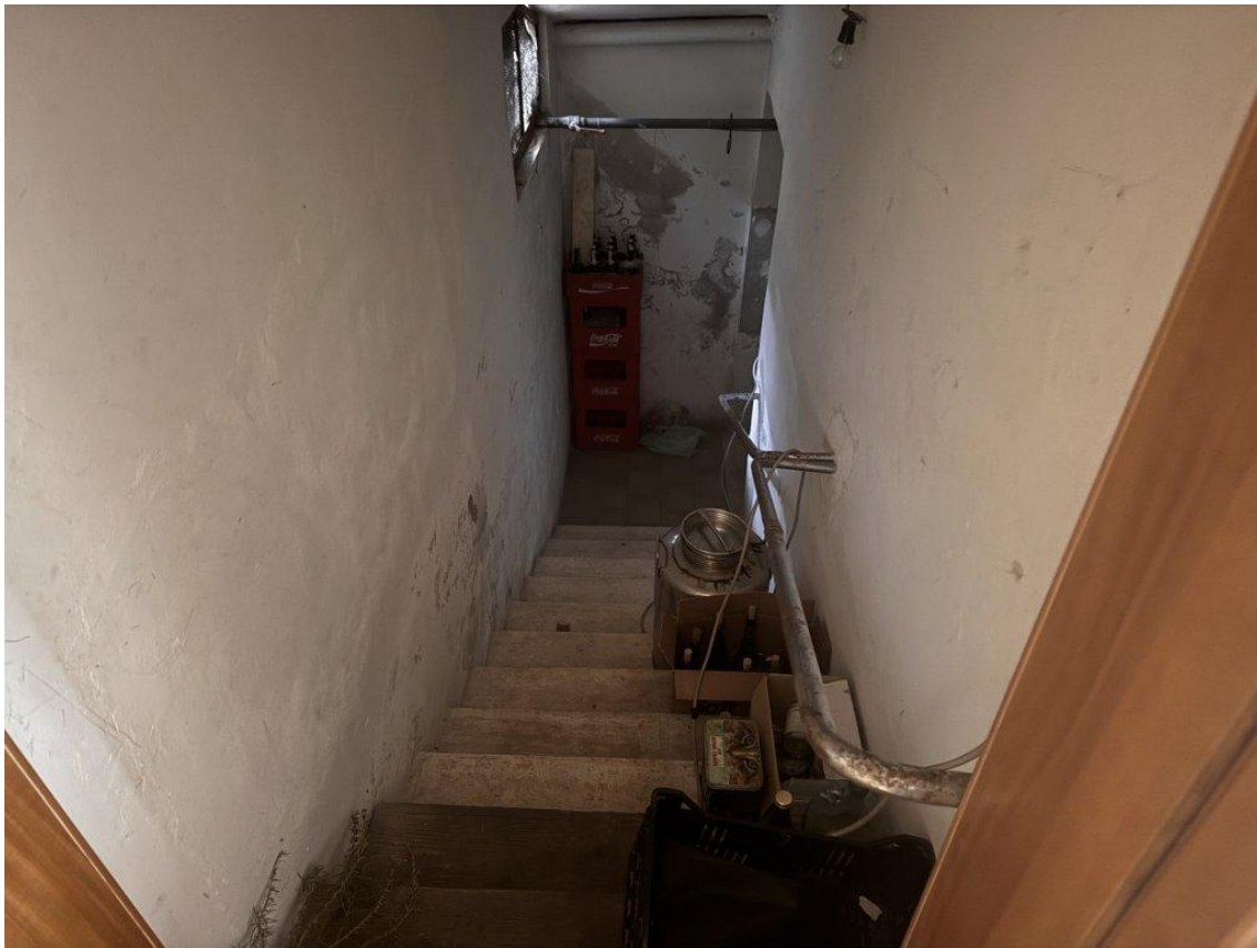
18. Vista della scala d'accesso al piano seminterrato
