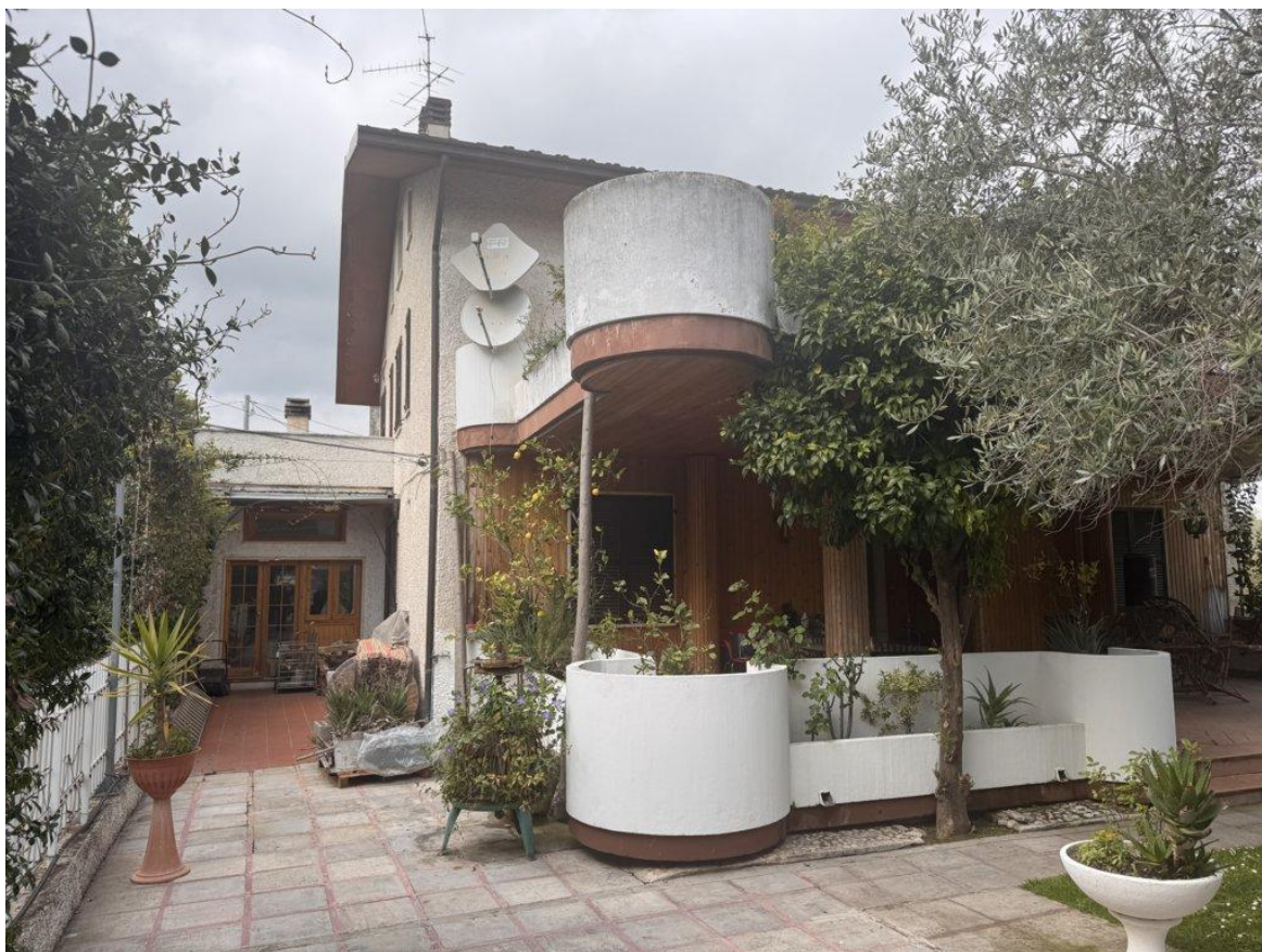
4. Vista angolo sud-ovest del fabbricato
