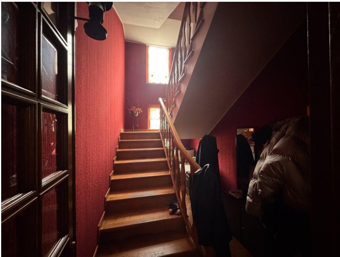
21. Vista della scala interna d'accesso al piano primo
