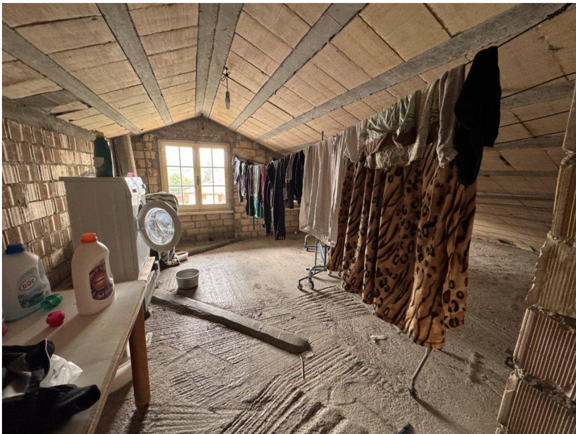
30. Vista interna del piano secondo (sottotetto)
