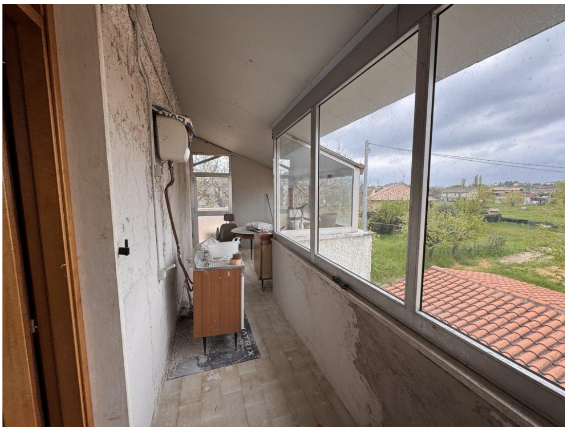
27. Vista della veranda ricavata mediante la chiusura perimetrale con infisso di parte del terrazzo sul lato nord
