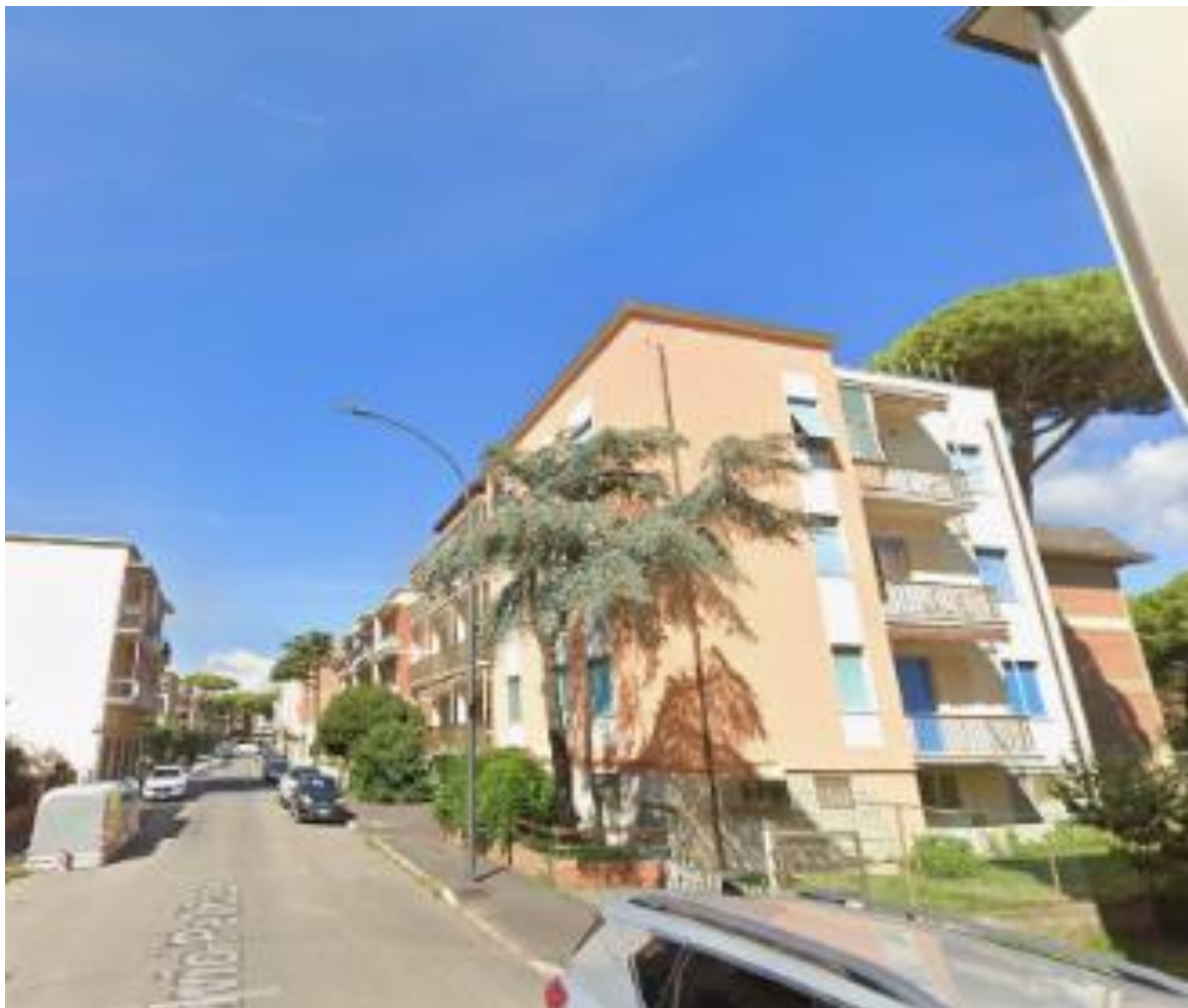
Figura 5 – Vista d'insieme del fabbricato da via Silvio Pellico
