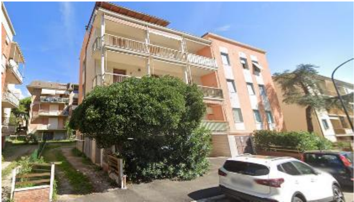
Figura 4 – Vista d'insieme del fabbricato da via Silvio Pellico
