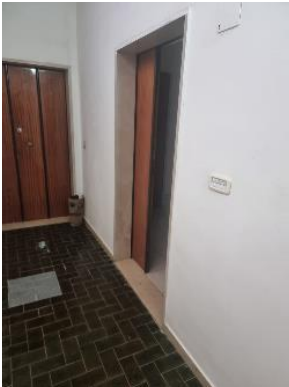
Figura 6-Vista accesso al corridoio comune dal vano scale
