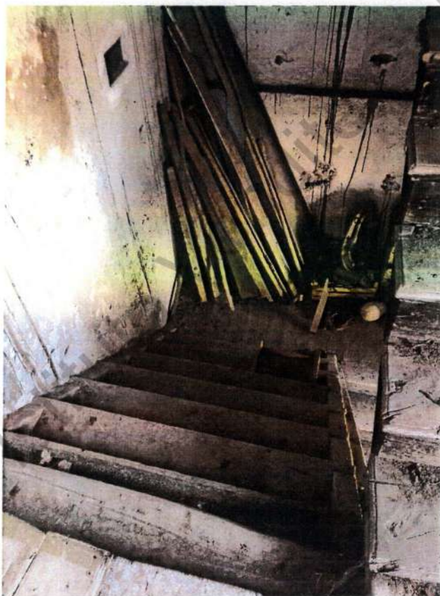
Foto 6 – Particolare vano scale mapp.436
