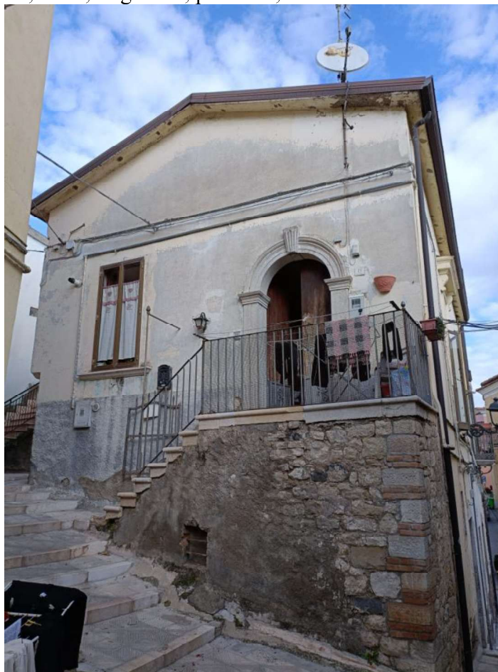
Figura 1 – Ingresso Abitazione, Vico Ortigara, n. 15.
