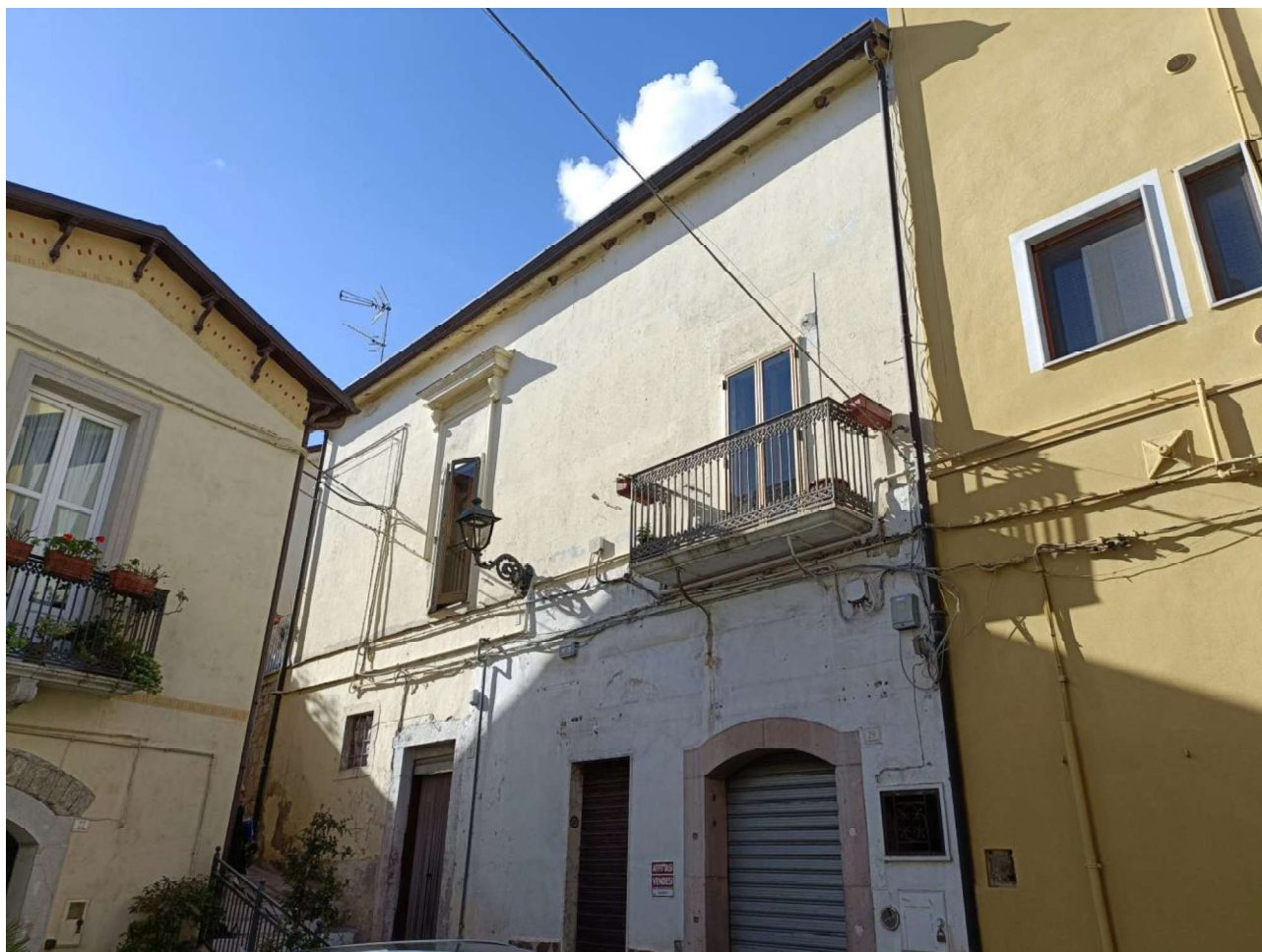
Figura 2 – Panoramica Prospetto Anteriore.
