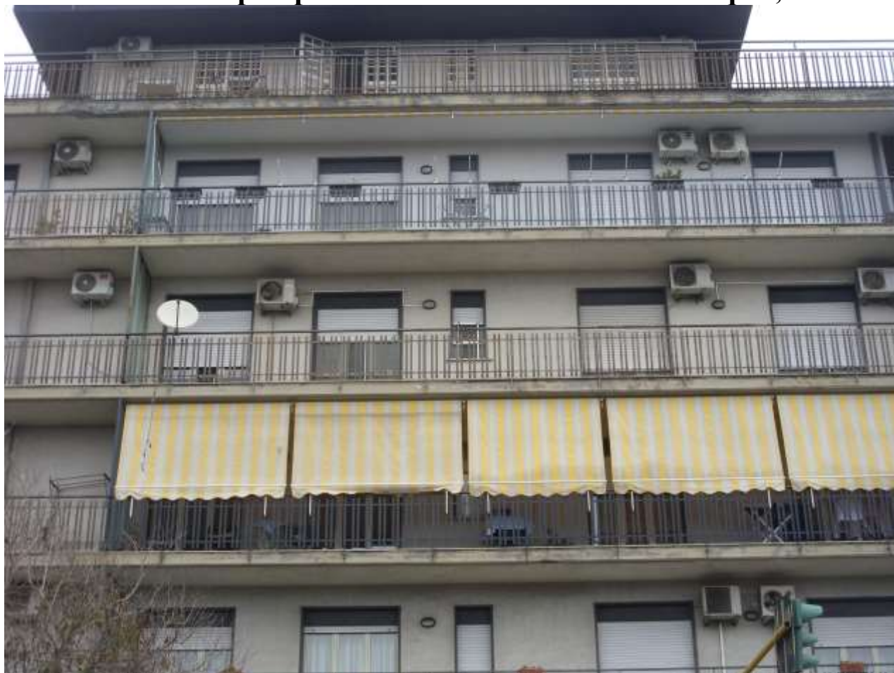
Balcone su prospetto Sud su via Montenero da mq 18,10
