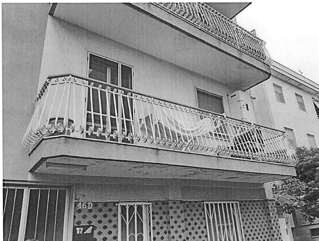
Foto 2 – Vista balcone Piano 1
