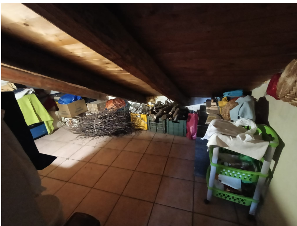
FOTO 11: vano deposito ricavato nella parte bassa della falda di copertura.
