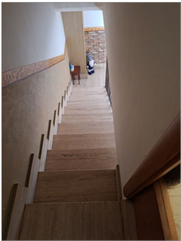
Scala interna in c.a. di collegamento piano terra e primo
