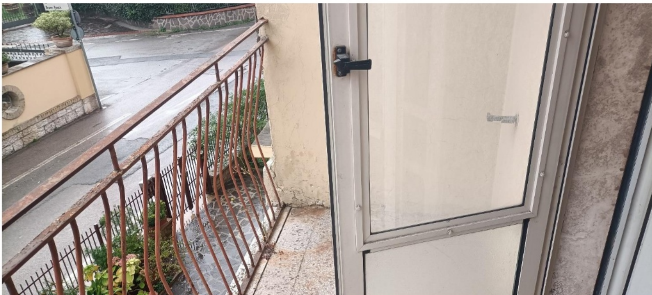
Foto n.11: Particolare del terrazzo con affaccio frontestrada.
