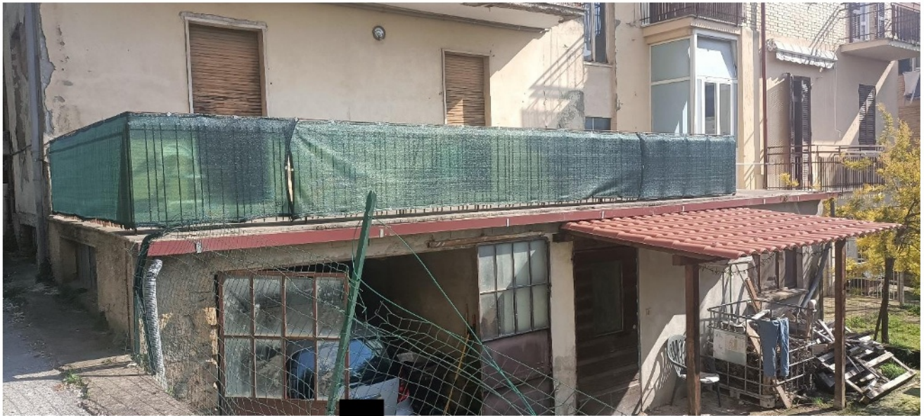
Foto n.13: altro particolare del piano primo sottostrada.
