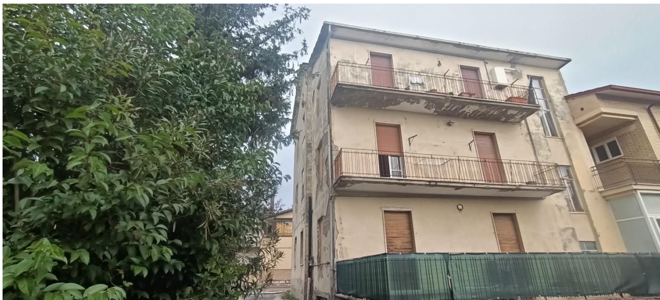
Foto n.3: Veduta del retroprospetto sud-est dell'edificio dove è visibile l'appartamento al piano primo esecutato con il particolare delle portafinestre delle due camere e del terrazzo.
