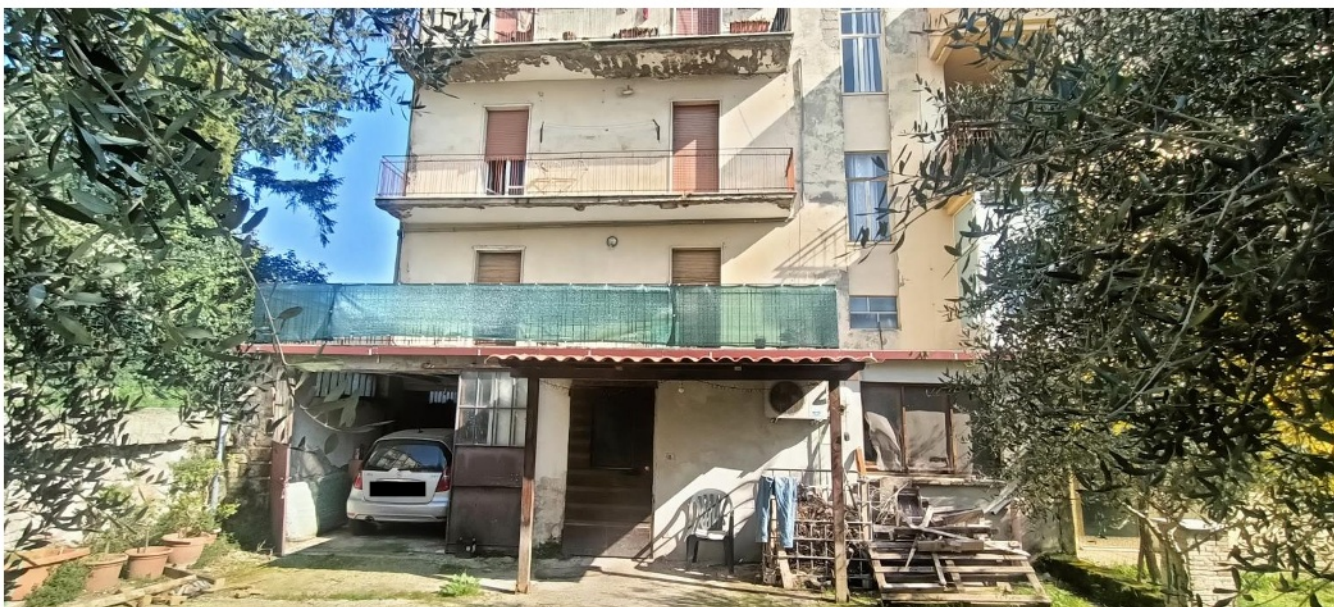
Foto n.12: veduta del retro del fabbricato dove, al piano primo sottostrada, è presente la porzione eseguita censita come garage ma attualmente costituita da tre fondi. L'ingresso è ad oggi solo pedonale e rappresentato da un portoncino in legno e vetro protetto da una tettoia in legno con lastra di copertura ondulata.
