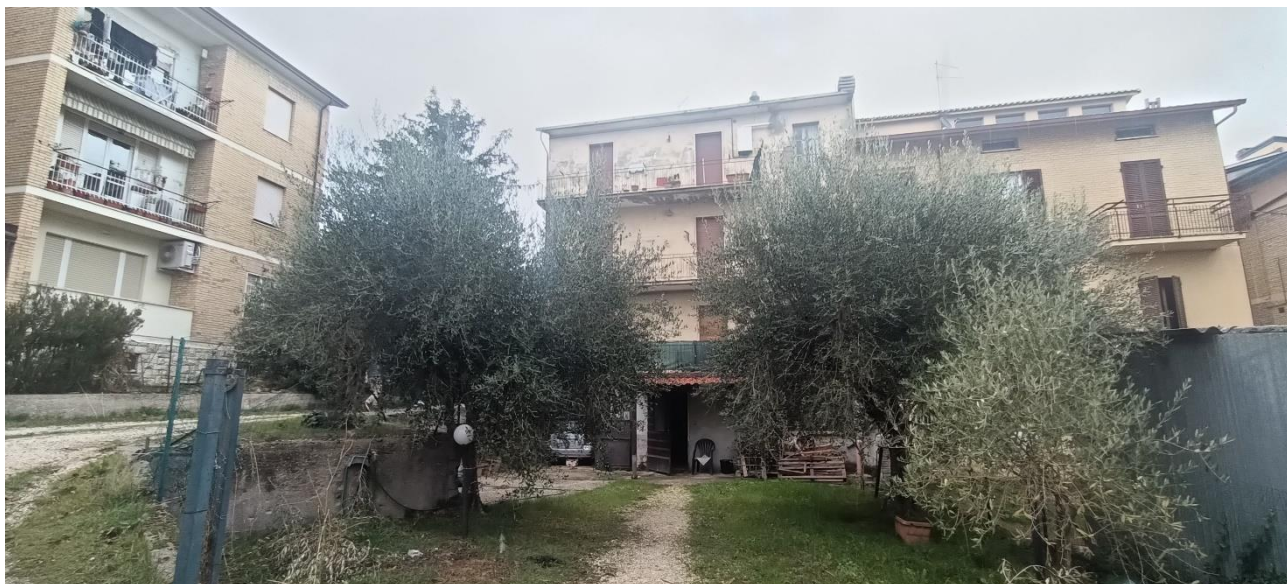
Foto n.4: altra veduta del retroprospetto del fabbricato dove è visibile il piano primo sottostrada e la corte comune censita al C.T. al Foglio 99, particella 235.
