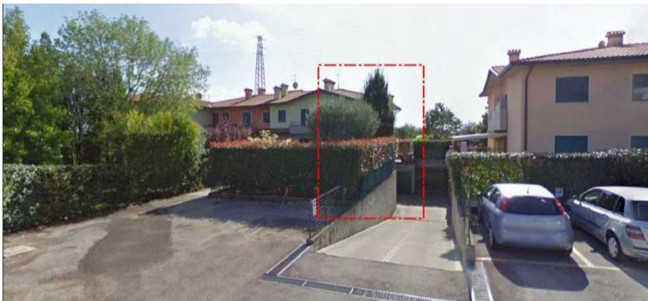
Fronte principale, vista nord – accessi pedonale e carroio
