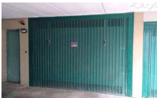
Esterno garage e porta centrale termica
