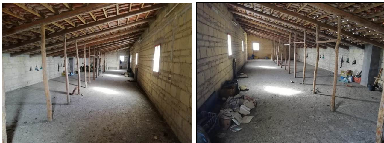
Vista interna del locale sottotetto
