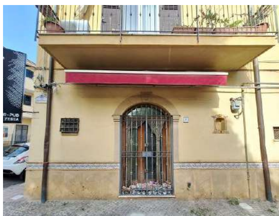
Prospetto sulla Via Consolare
