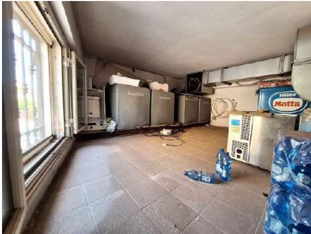
Vista del soppalco dal W.C.
