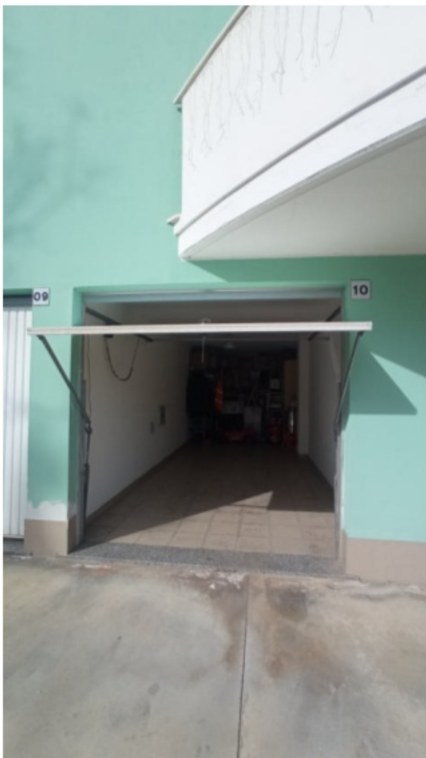
INGRESSO BOX AUTO SUB.5
