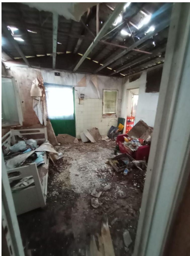
FOTO 16 - 17. Viste del vano principale
