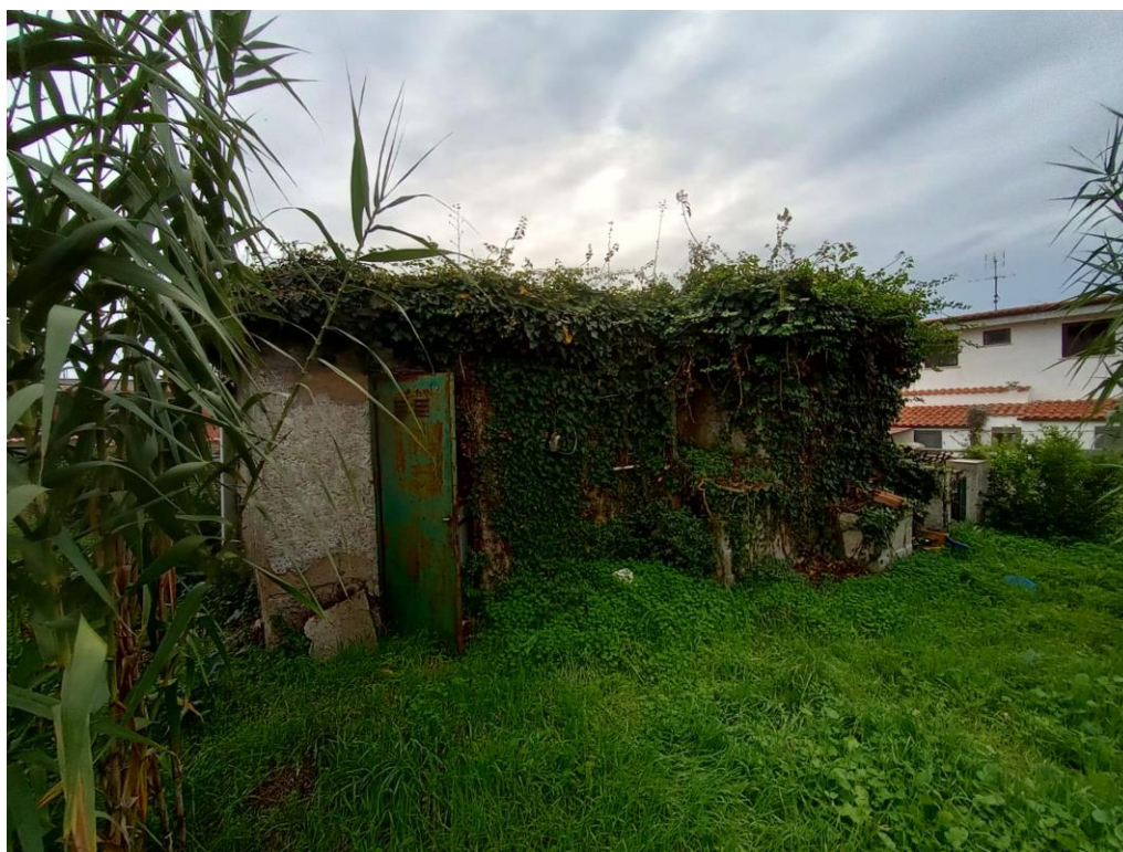
FOTO 6. Vista esterna dalla parte laterale lato Ovest
