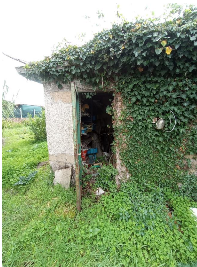
FOTO 10. Vista accesso al vano tecnico
