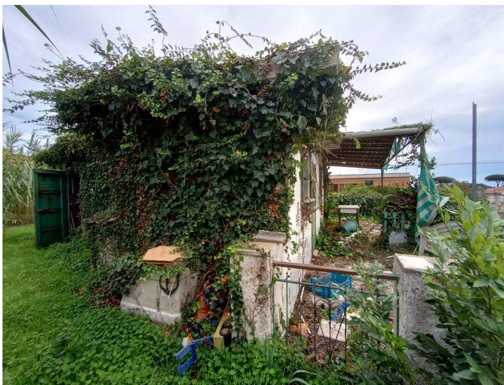
FOTO 7. Vista esterna (lato Sud-Ovest)
