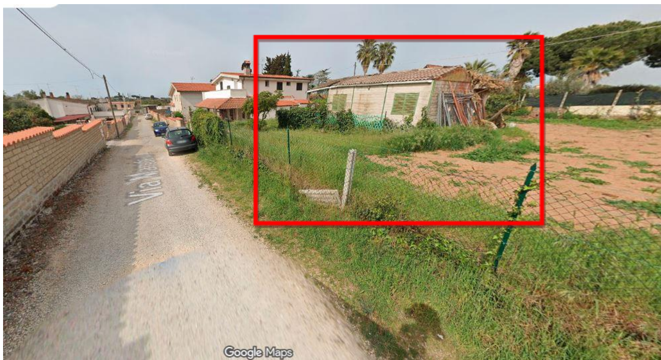
FOTO 1 - 2. Viste da via Mandela
