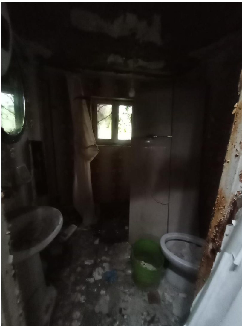
FOTO 20. Vista del bagno
