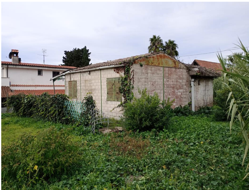
FOTO 5. Vista esterna dalla parte posteriore (lato Nord-Est)
