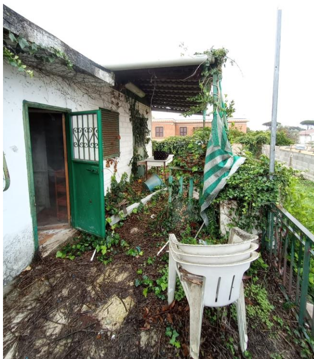
FOTO 9. Vista del patio
