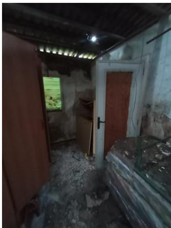
FOTO 18 - 19. Viste della camera
