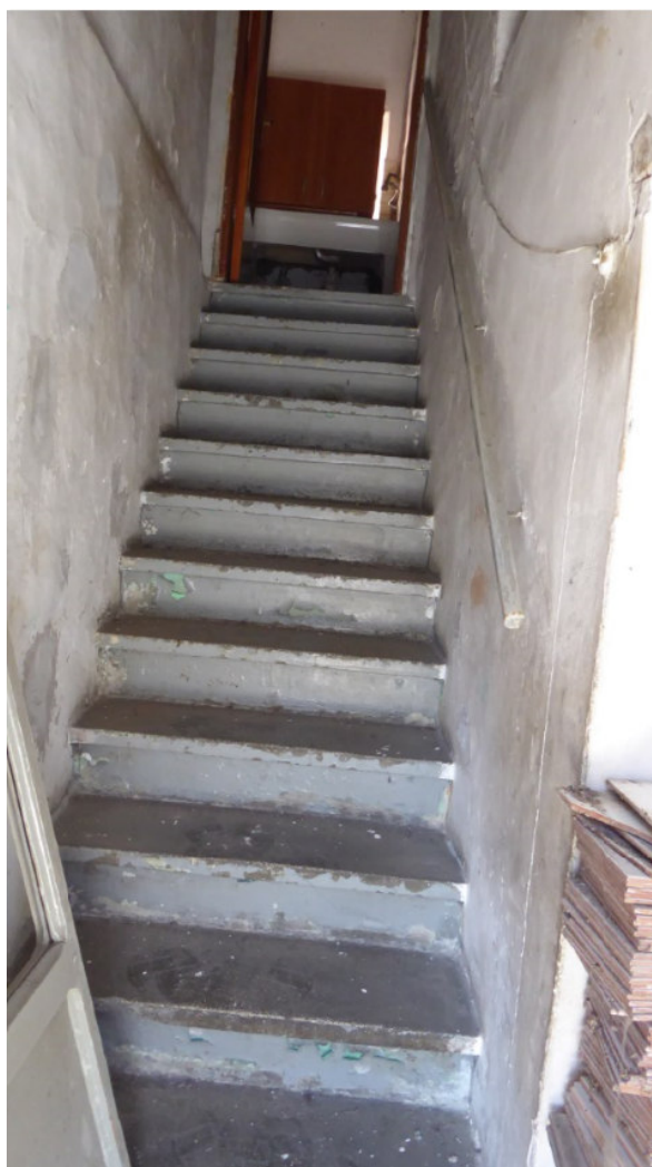
F.5: Vista delle scale dal p.terra al p.1
