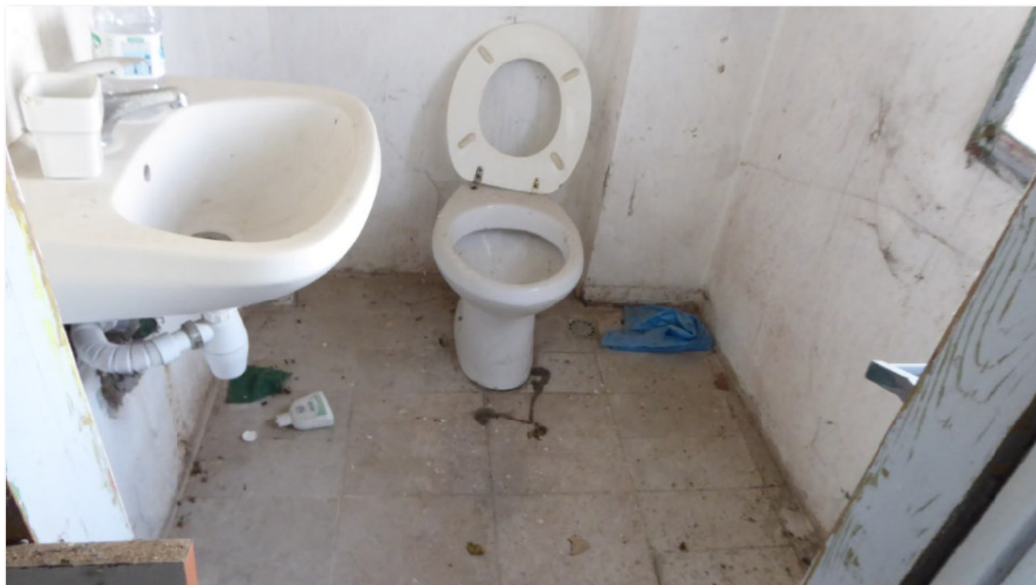
F.11: Vista del wc al p.2
