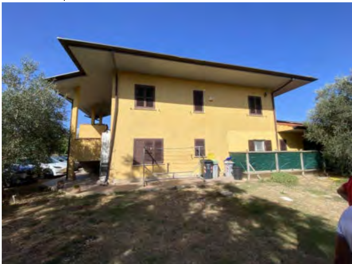
Foto n. 12 - Prospetto laterale casa colonica
