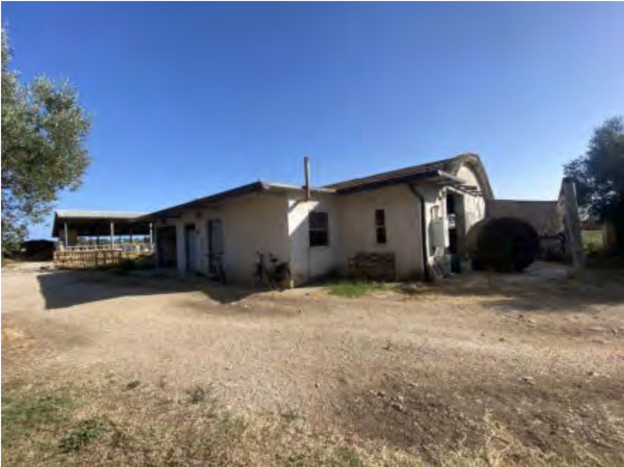
Foto n. 13 - Stalla vista esterna
