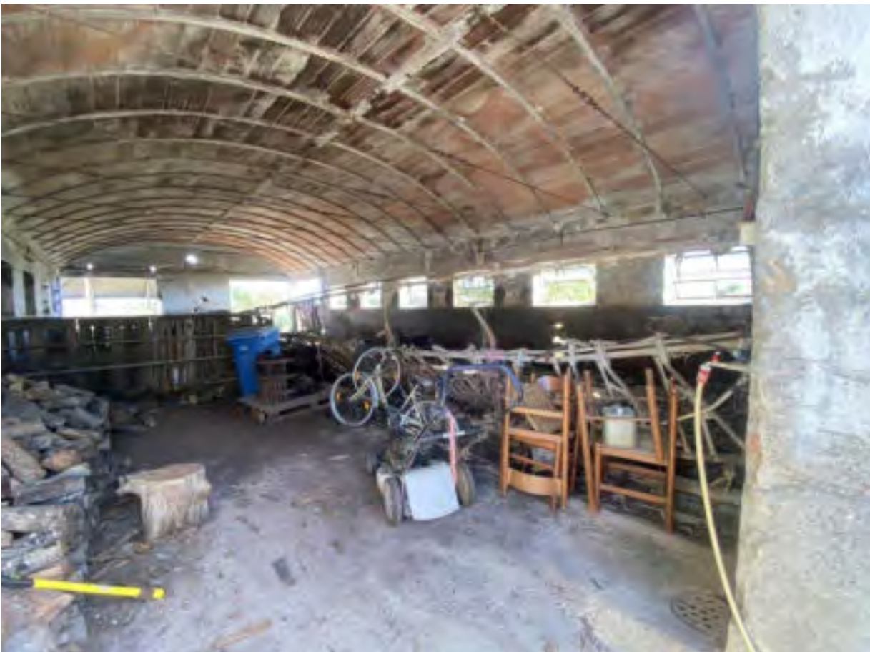
Foto n. 14 - Stalla vista interna
