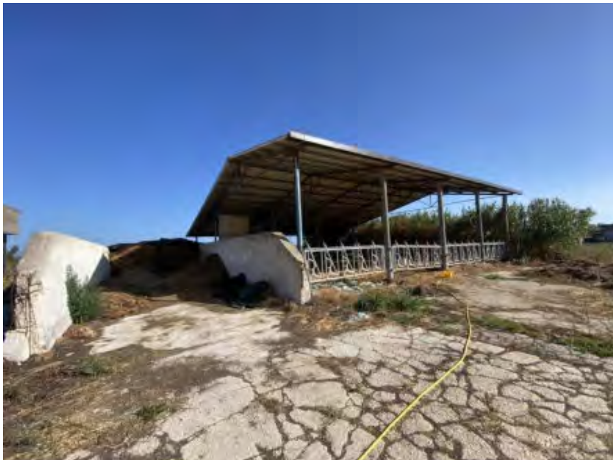
Foto n. 15 - Fienile e silos vista esterna
