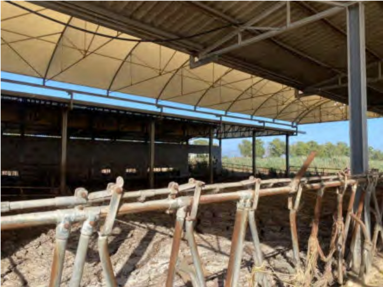
Foto n. 17 - Stalla stabulazione vista interna
