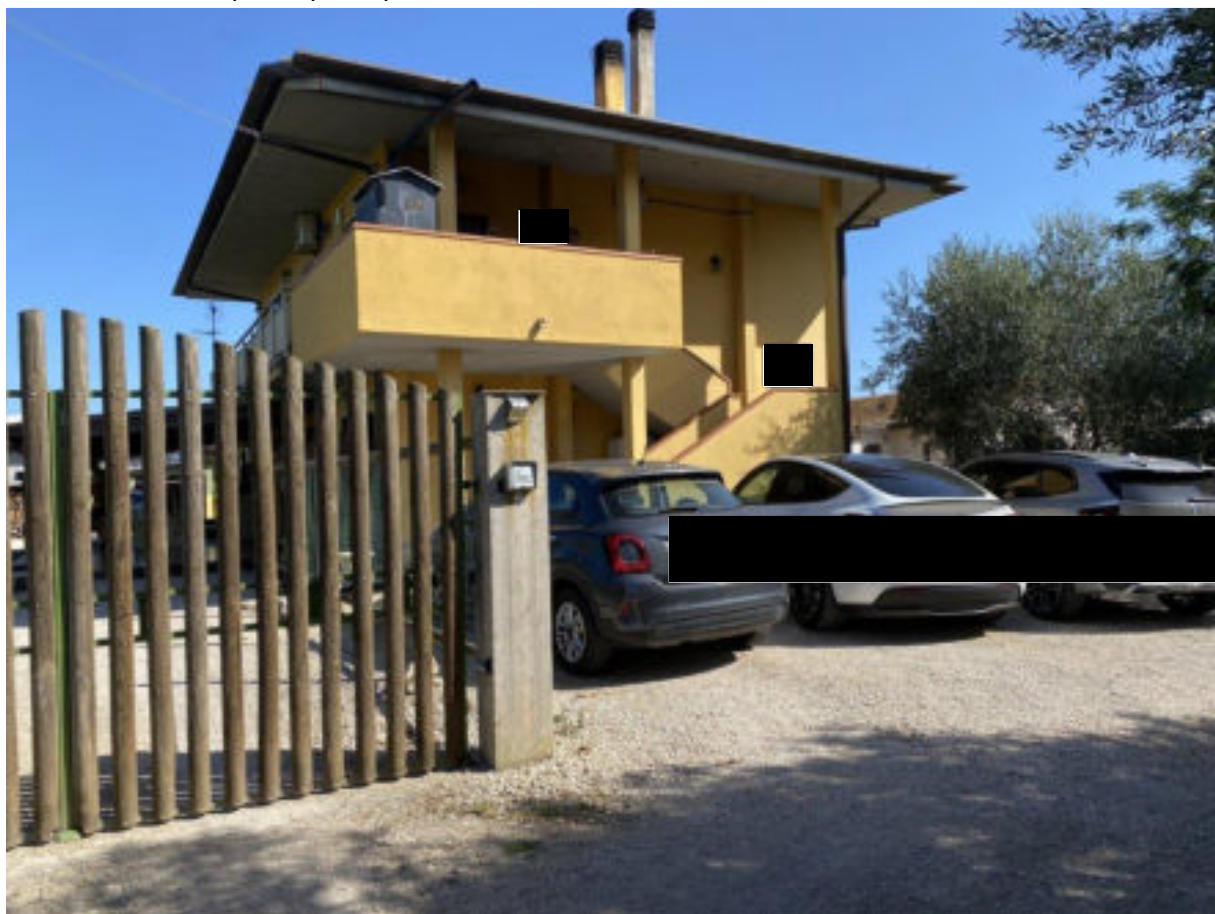
Foto n. 11 - Prospetto principale casa colonica
