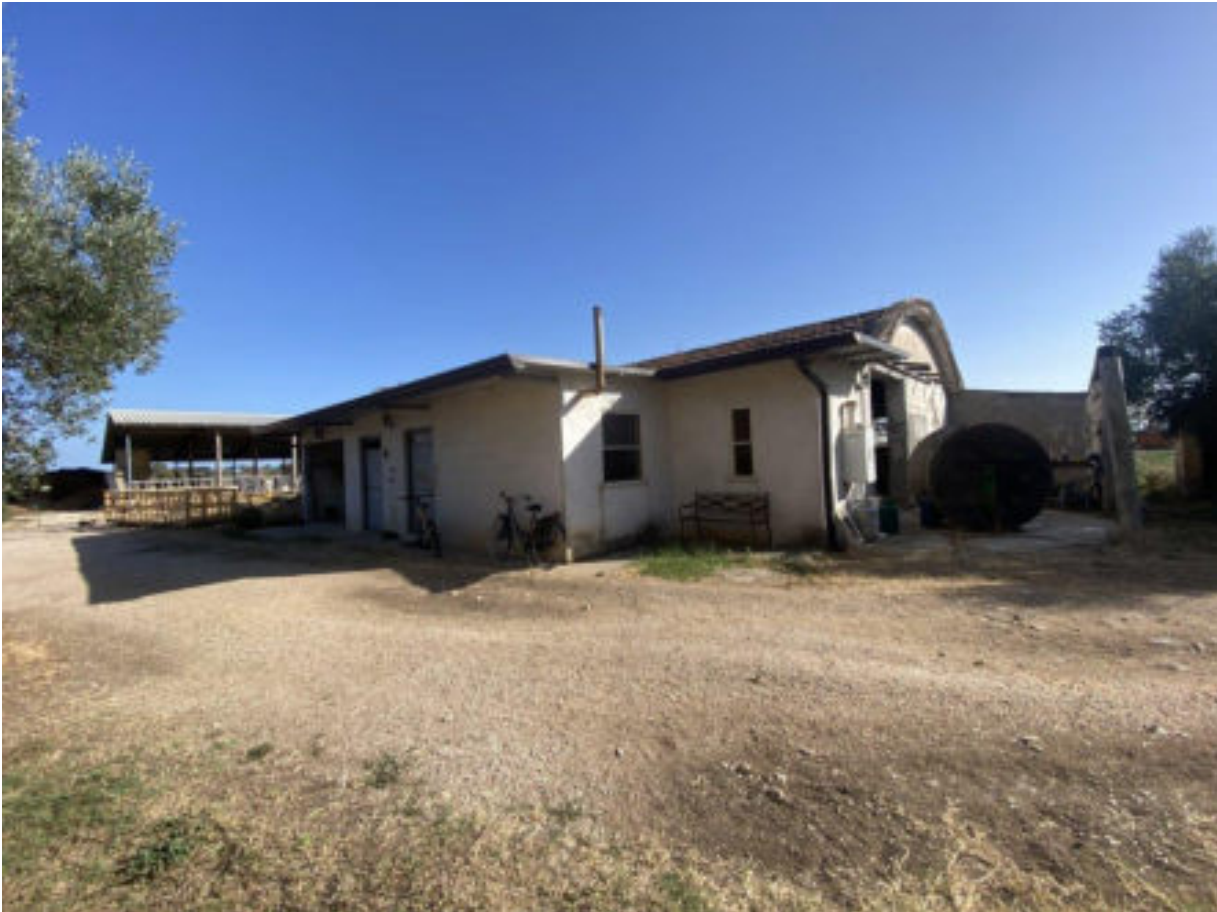
Foto n. 13 - Stalla vista esterna
