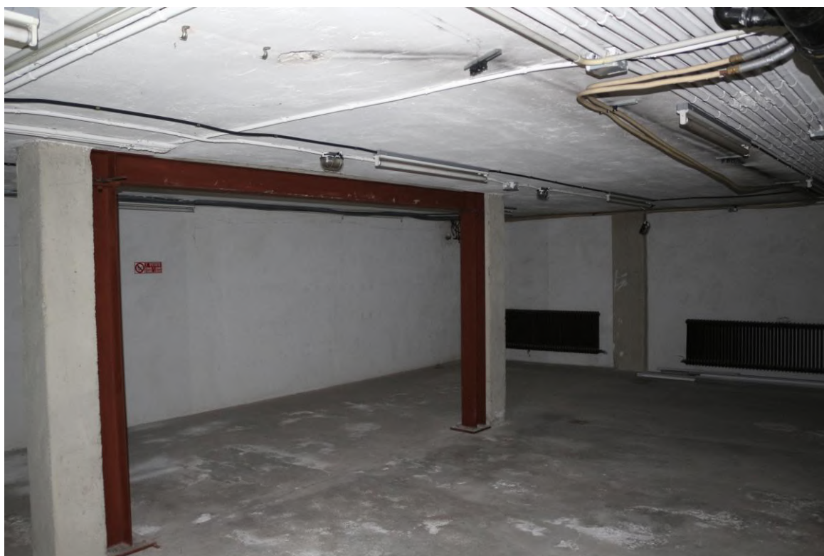
FOTO N°12. - visione interna - PIANO INTERRATO
