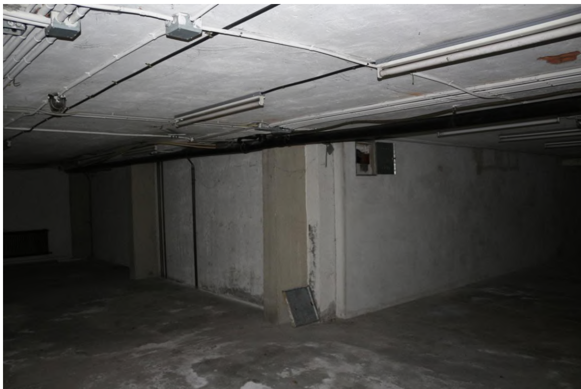
FOTO N°11. - visione interna - PIANO INTERRATO
