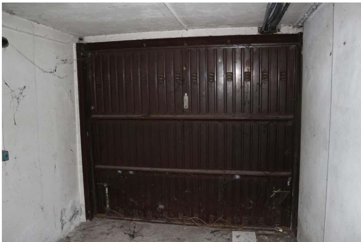
FOTO N°15. - visione interna – PIANO INTERRATO
