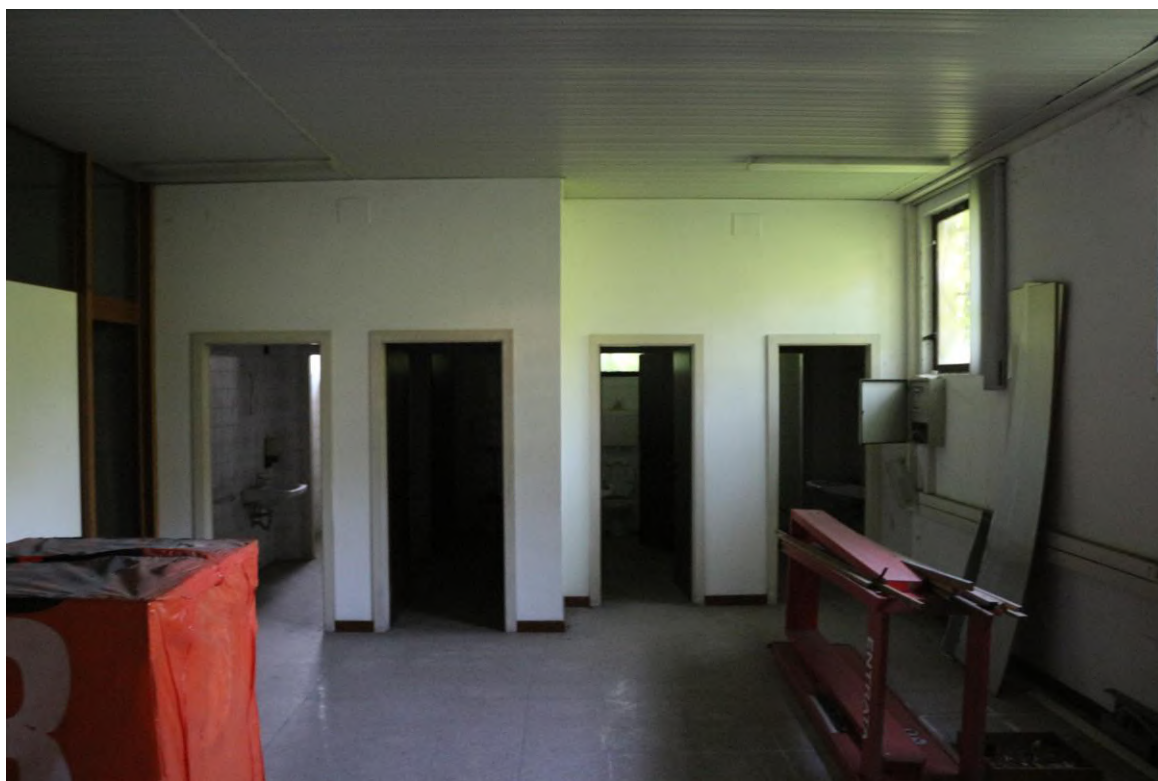
FOTO N°6. - visione interna – PIANO TERRA
