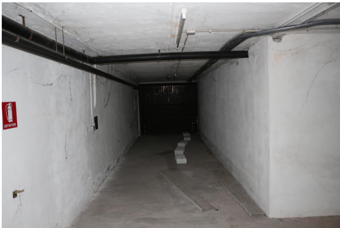
FOTO N°13. - visione interna - PIANO INTERRATO
