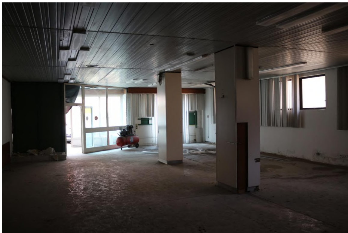
FOTO N°5. - visione interna – PIANO TERRA
