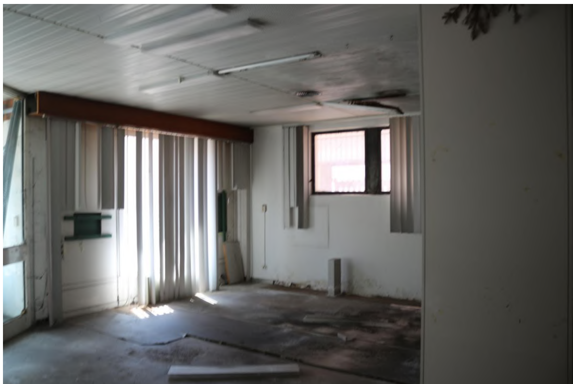
FOTO N°9. - visione interna – PIANO TERRA
