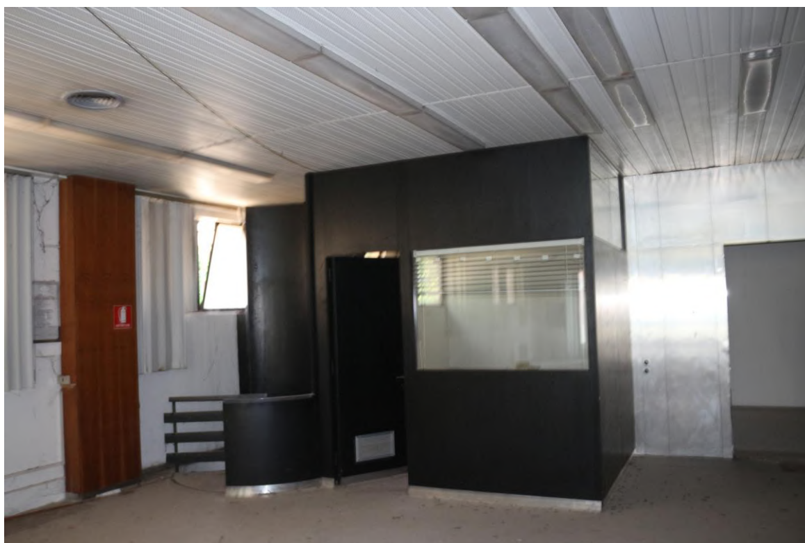
FOTO N°4. - visione interna – PIANO TERRA
