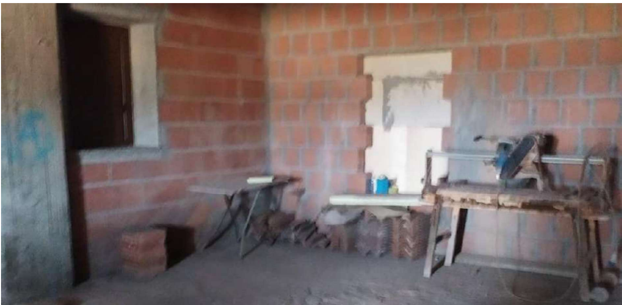
Foto 51 – Foglio 24 p.lla 169, sub 28- SOTTOTETTO
