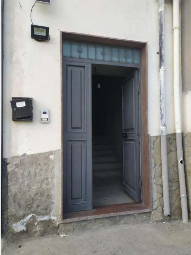
Foto 42 – Foglio 24 p.lla 169, sub 16- SCALA
