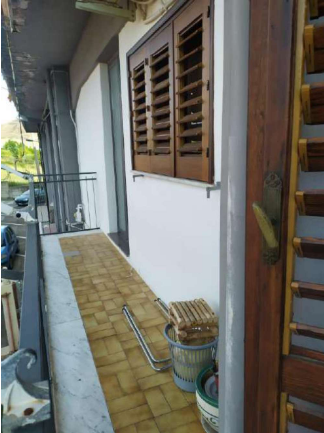
Foto 29 – Foglio 24 p.la 169, sub 2- BALCONE
