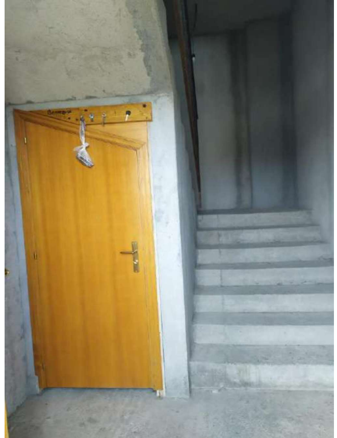
Foto 43 – Foglio 24 p.lla 169, sub 16- SCALA
