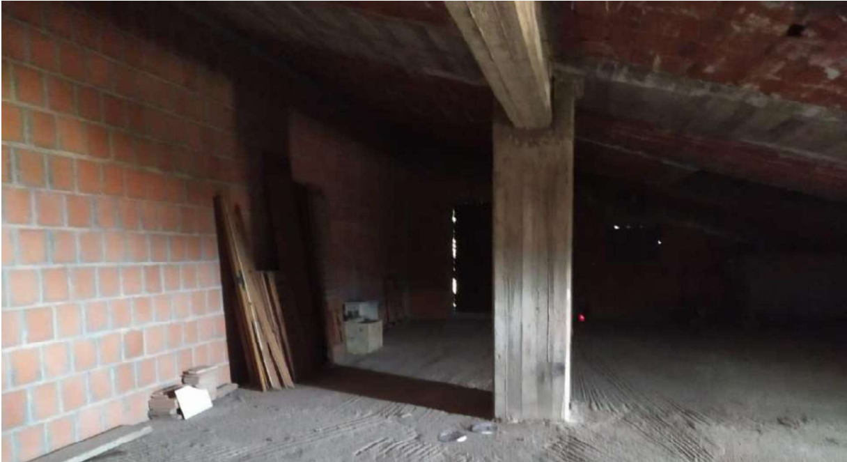
Foto 50 – Foglio 24 p.lla 169, sub 28- SOTTOTETTO
