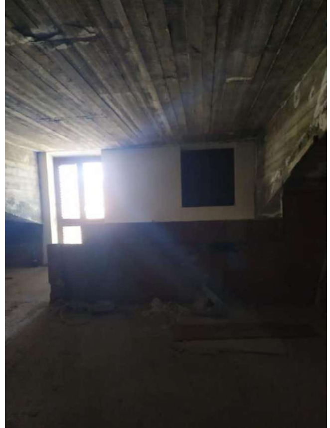
Foto 49 – Foglio 24 p.lla 169, sub 28- SOTTOTETTO
