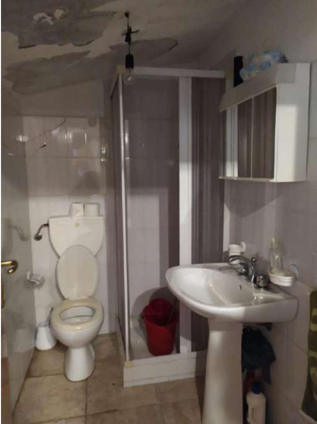
Foto 37 – Foglio 24 p.la 169, sub 20- SOTTOTETTO
