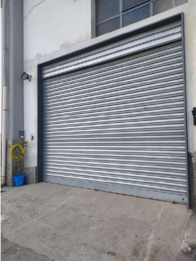
Foto 41 – Foglio 24 p.lla 169, sub 24- GARAGE
