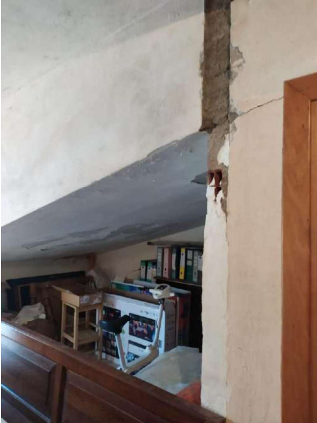
Foto 35 – Foglio 24 p.lla 169, sub 20- SOTTOTETTO
