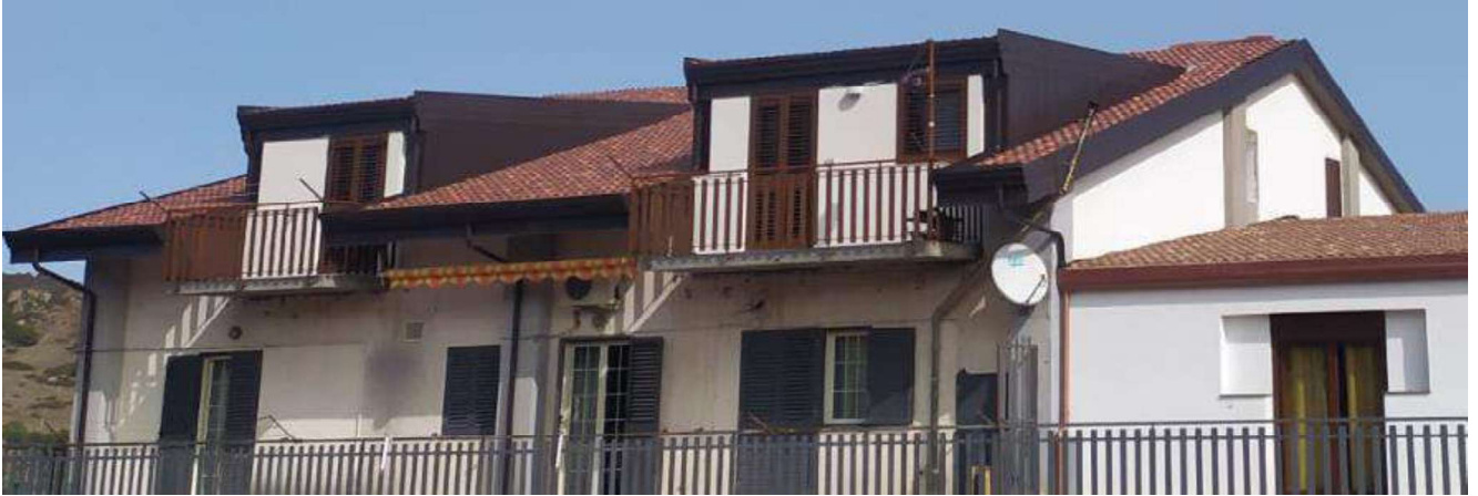
Foto 54 – Foglio 24 p.lla 169, sub 29- SOTTOTETTO
