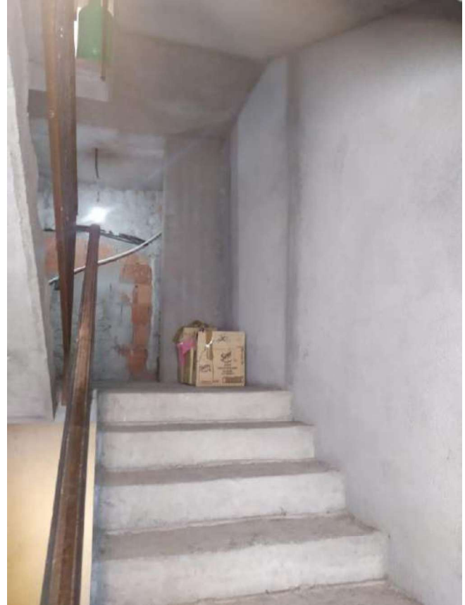
Foto 45 – Foglio 24 p.lla 169, sub 17- SCALA
