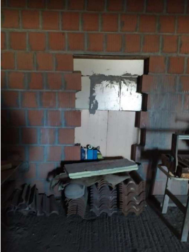
Foto 52 – Foglio 24 p.lla 169, sub 28- SOTTOTETTO
