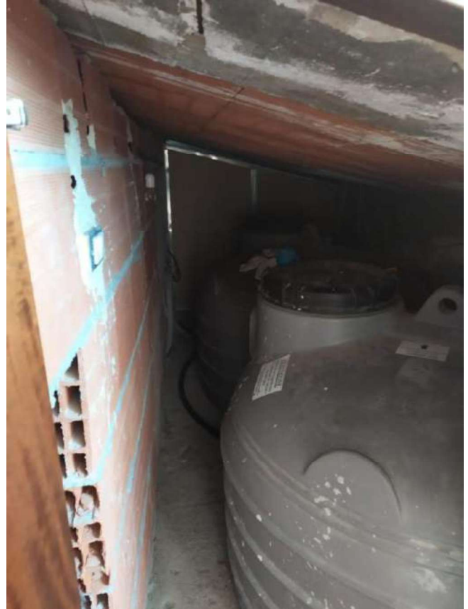
Foto 40 – Foglio 24 p.la 169, sub 20- SOTTOTETTO
