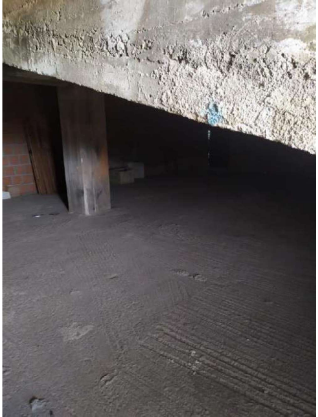
Foto 53– Foglio 24 p.lla 169, sub 28- SOTTOTETTO
