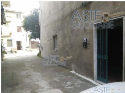
INGRESSO CORPO SCALA LATO EST
