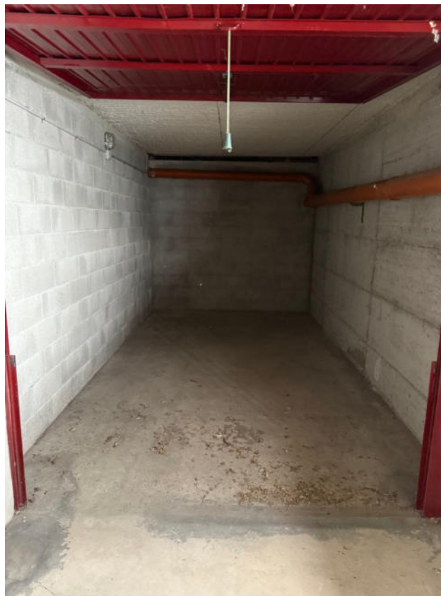
Foto 3 Interno box sub.23 p.S1
