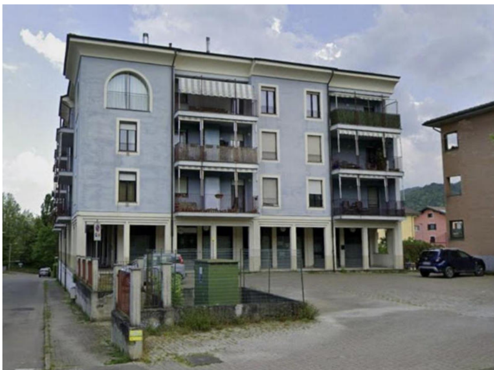
Foto 1 Prospetto ovest Condominio “Azzurro Ventino”
