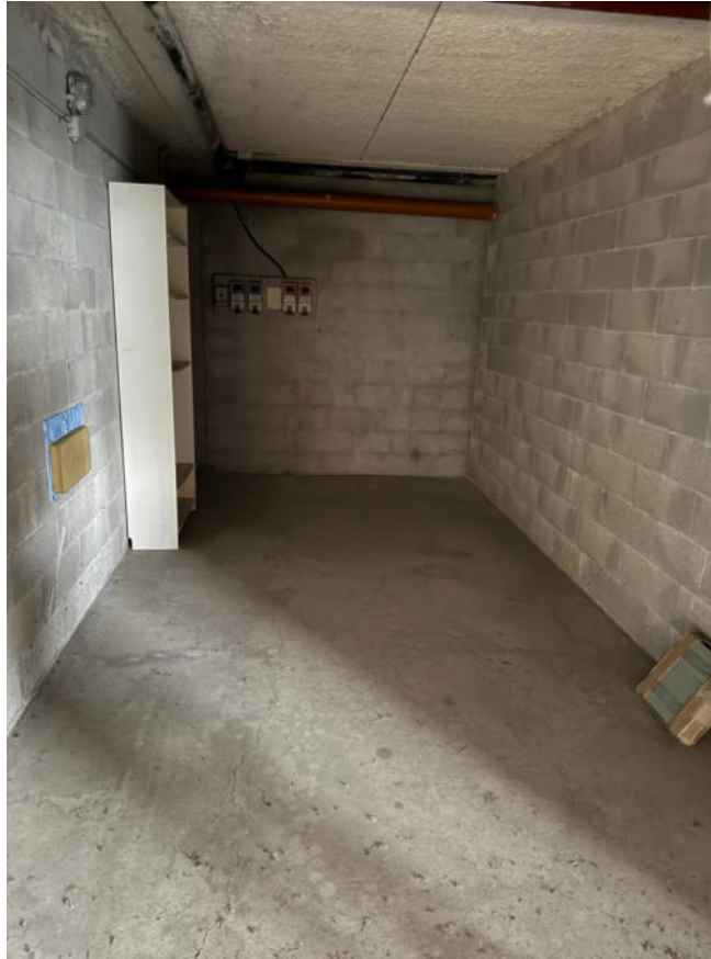
Foto 5 Interno box sub.22 p.S1
