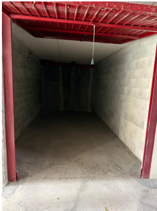
Foto 4 Interno box sub.20 p.S1
