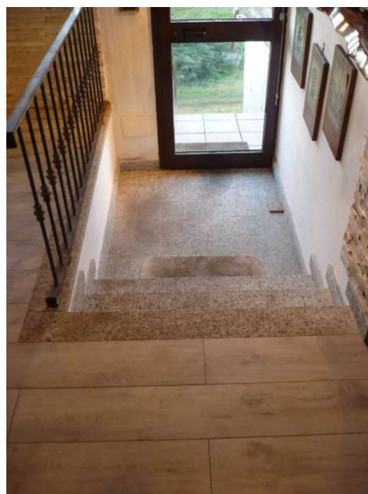
22 – Vista ingresso da cortile
