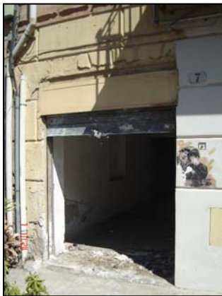
Foto n. 3 – Vista vano di ingresso
