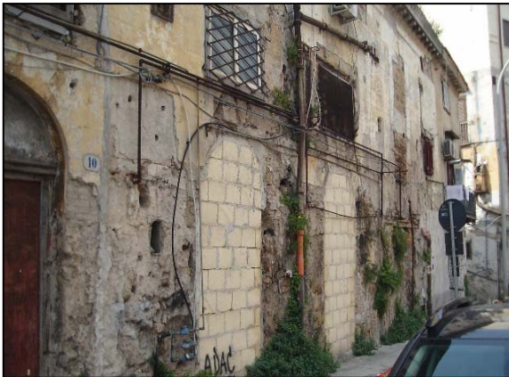
Foto n. 3 - Vista esterna edificio
