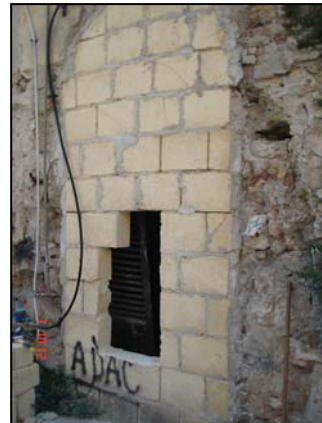
Foto n. 4 - Vista vano di accesso
