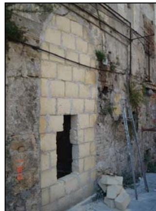
Foto n. 4 - Vista vano di accesso
