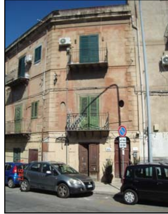
Foto n. 2 - Vista esterna edificio
