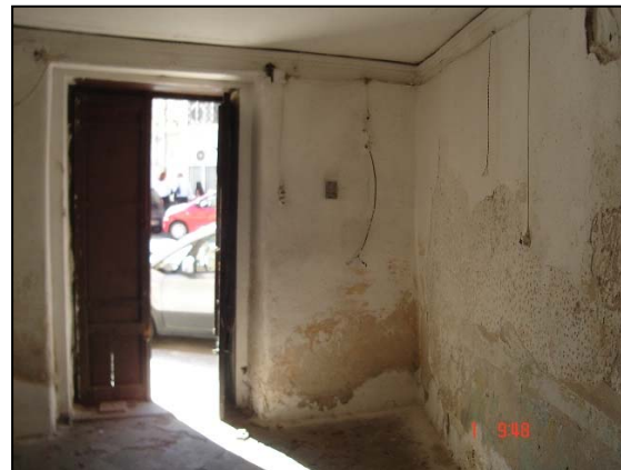
Foto n. 4 - Vista vano principale
