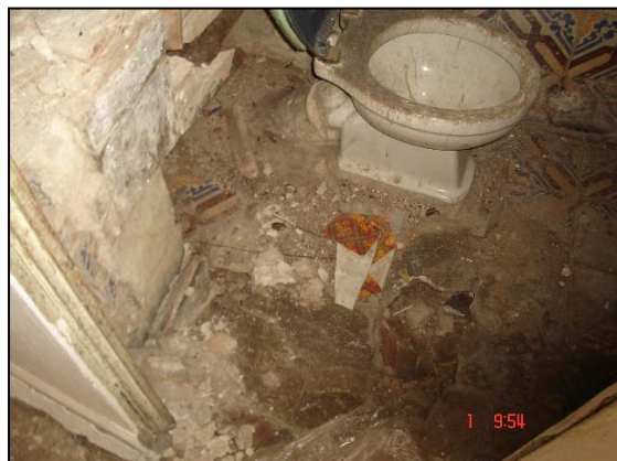
Foto n. 6 - Vista vano con w.c.
