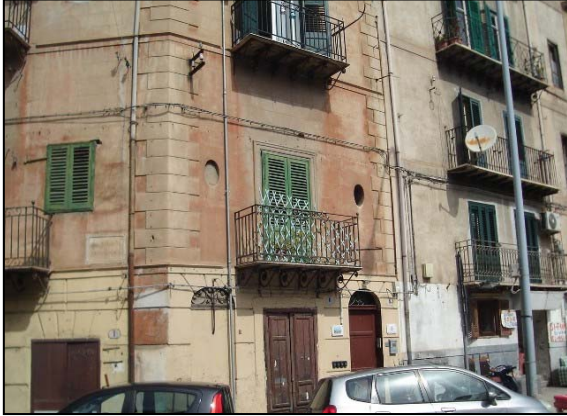
Foto n. 1 - Vista esterna edificio
