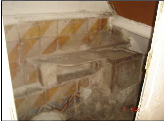
Foto n. 7 – Vista vano con w.c.
