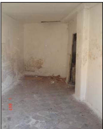
Foto n. 5 - Vista vano principale
