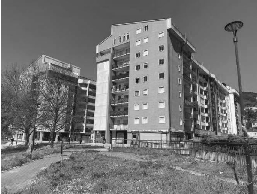
Foto n. 1 Complesso immobiliare in primo piano edificio Y
