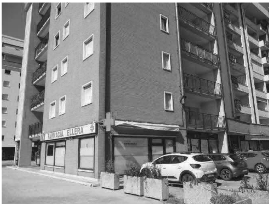
Foto n. 4 Primo piano edificio Y
