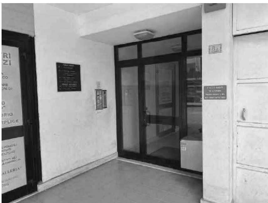
Foto n. 5 Ingresso edificio Y scala A
