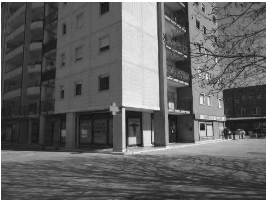
Foto n. 3 Primo piano edificio Y
