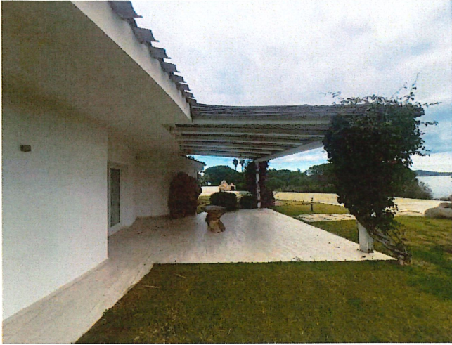
FOTO VERANDA PIANO TERRA
