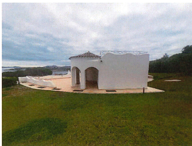
FOTO ESTERNO PIANO PRIMO
