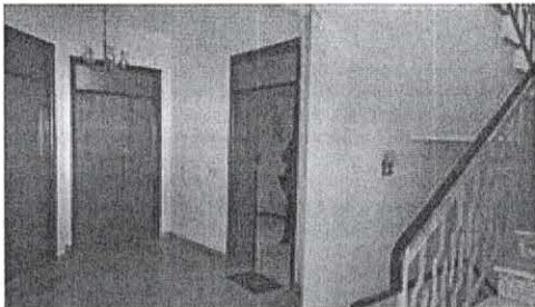
Vista porta di accesso unità immobiliare
