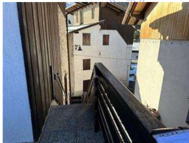
Scala di accesso al piano
