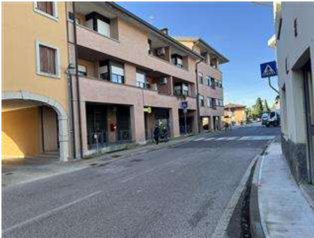
Veduta complesso immobiliare
