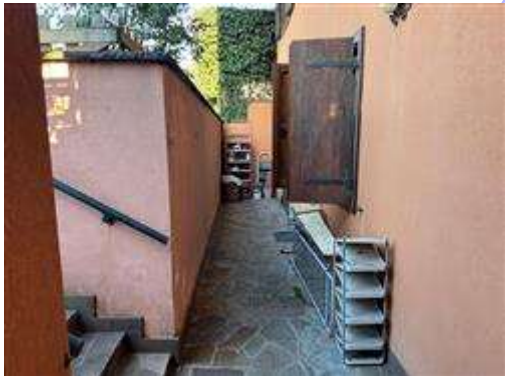
Accesso piano parzialmente interrato
