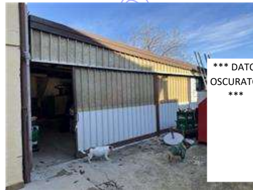
Fabbricato con struttura in ferro
