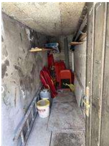
Vano servizi comune al piano terra
