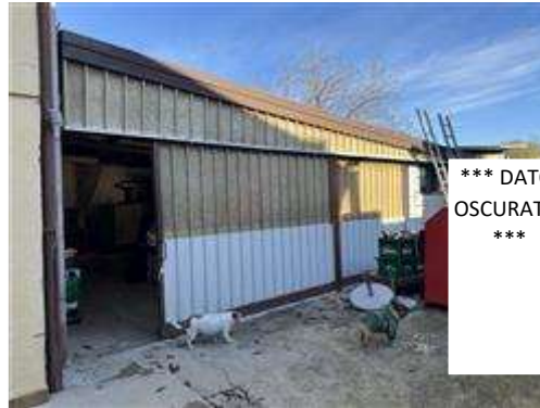
Capannone in ferro
